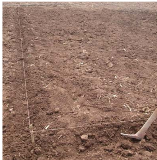
Fotografía 2: preparación del terreno
