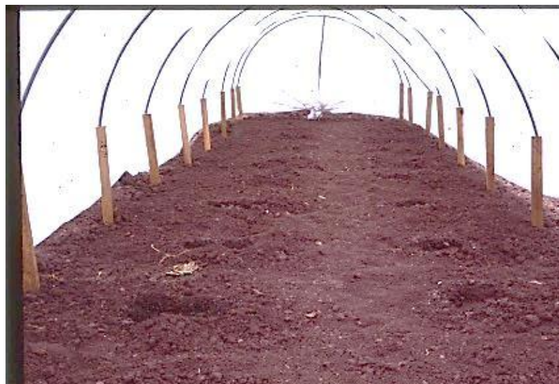
Fotografía 01: Estructura de construcción del fitotoldo (K'ayra).
