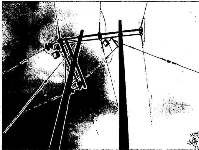
Foto N° 03: Armado tipo AT-3, con derivación DT-2 en el sector de Yupanca
