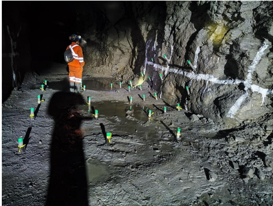
FIGURA 11: FRENTE DE TRABAJO CON TALADROS CARGADOS Y PATRÓN DE VOLADURA MARCADO.
