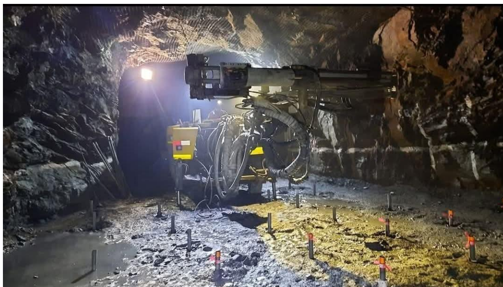
FIGURA 10: MALLA DE TALADROS LARGOS EJECUTADA.
