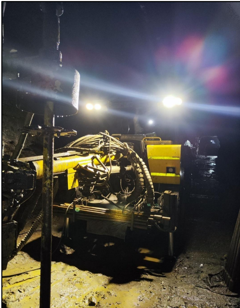
FIGURA 12: EJECUCIÓN EN CAMPO DEL PATRÓN DE PERFORACIÓN CON EQUIPO MECANIZADO.
