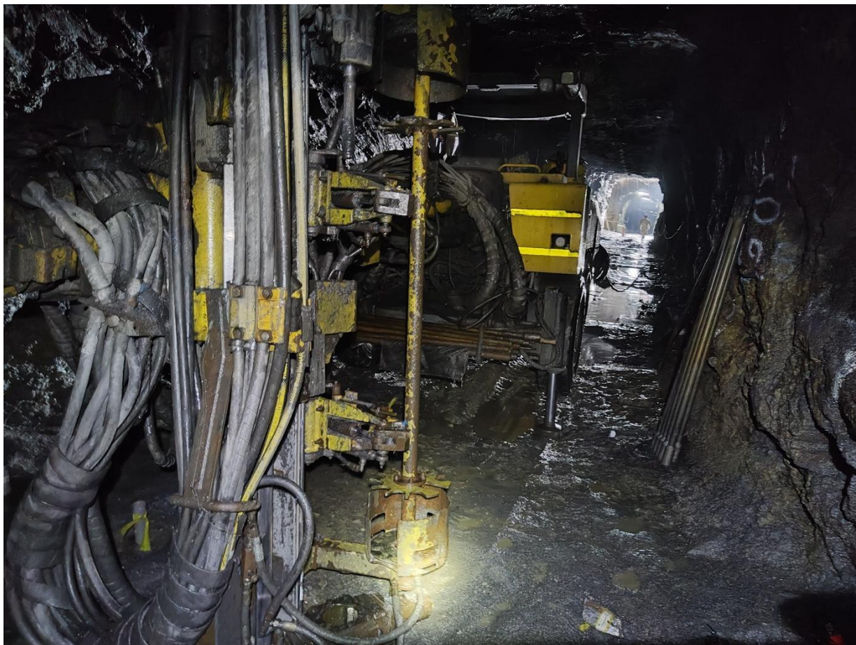
FIGURA 4: EQUIPO MECANIZADO DE PERFORACIÓN TIPO SIMBA EN OPERACIÓN DENTRO DEL TAJO N°3 – NV 4530.
