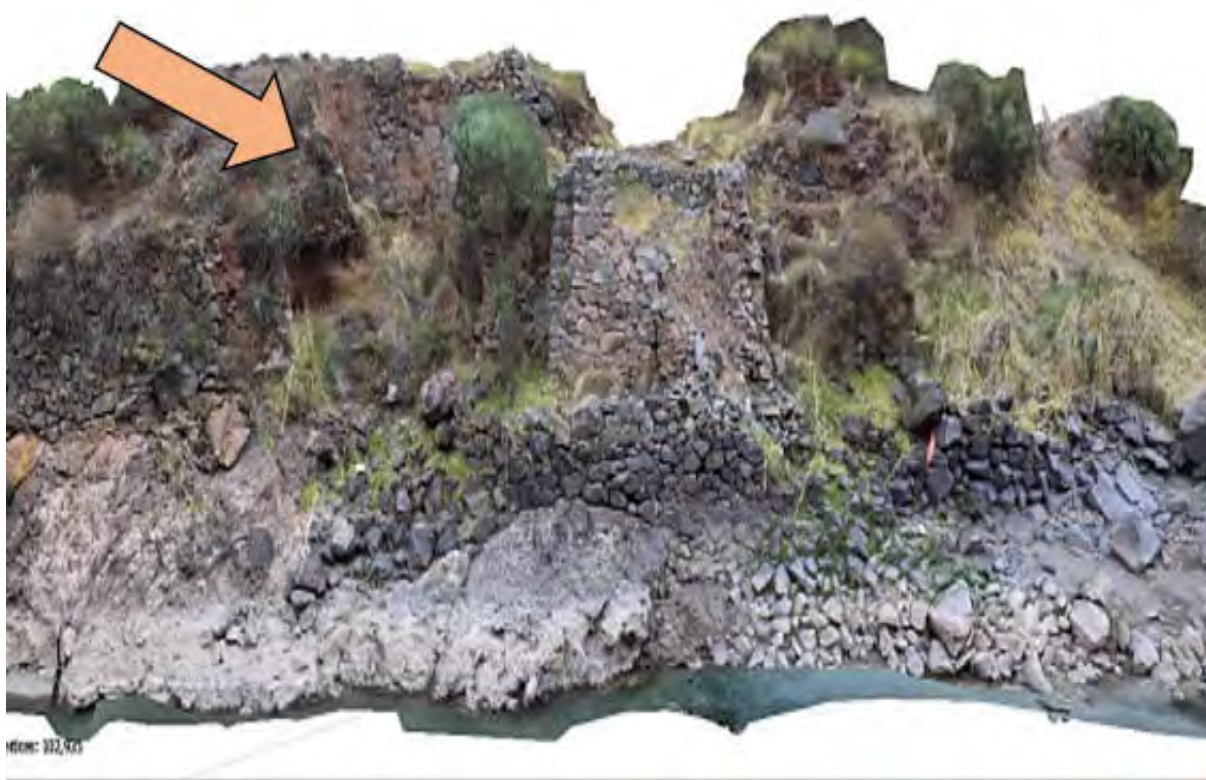
Figura 92. Muros de contención a los costados del estribo derecho.
