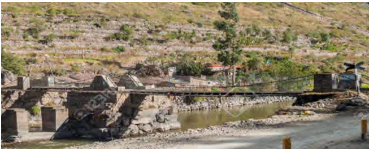
Figura 23. Puente de tres estribos con acondicionamiento de materiales.
