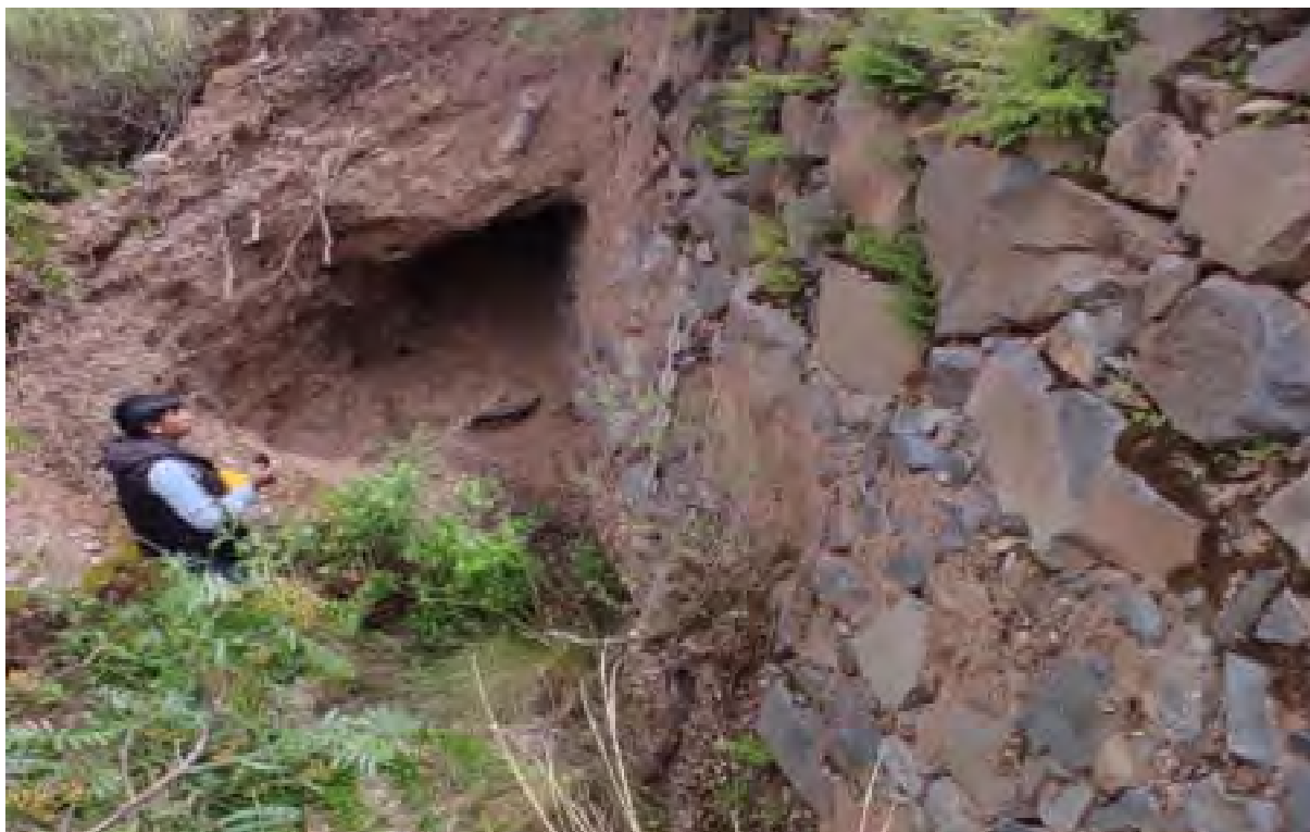
Figura 78. Muestra del muro de contención del estribo derecho.
