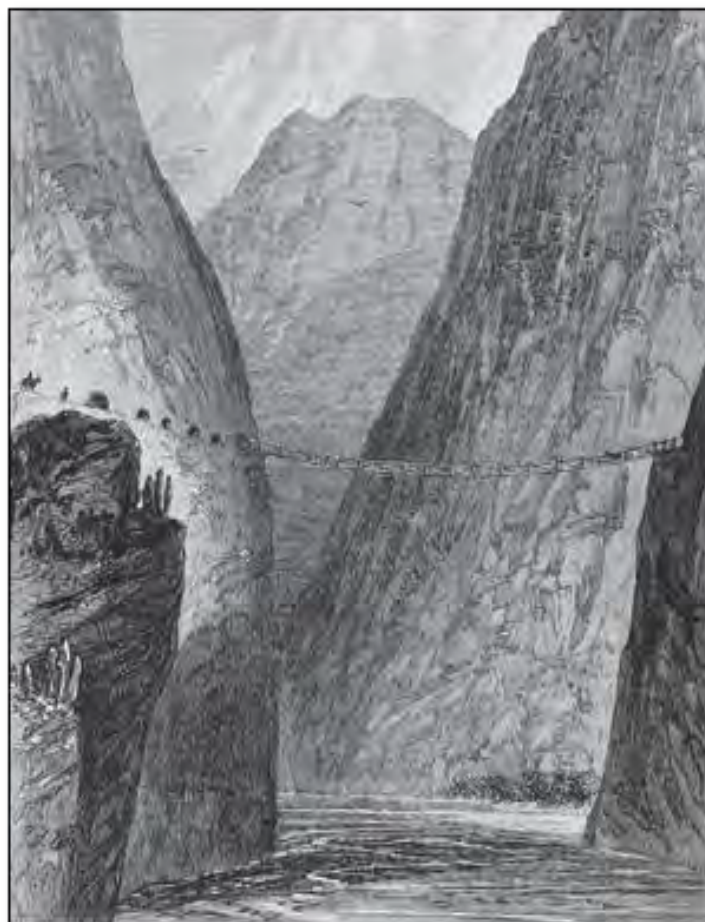
Figura 12. Puente del Apurímac (Fuente: ilustración de L. Gibbon).
