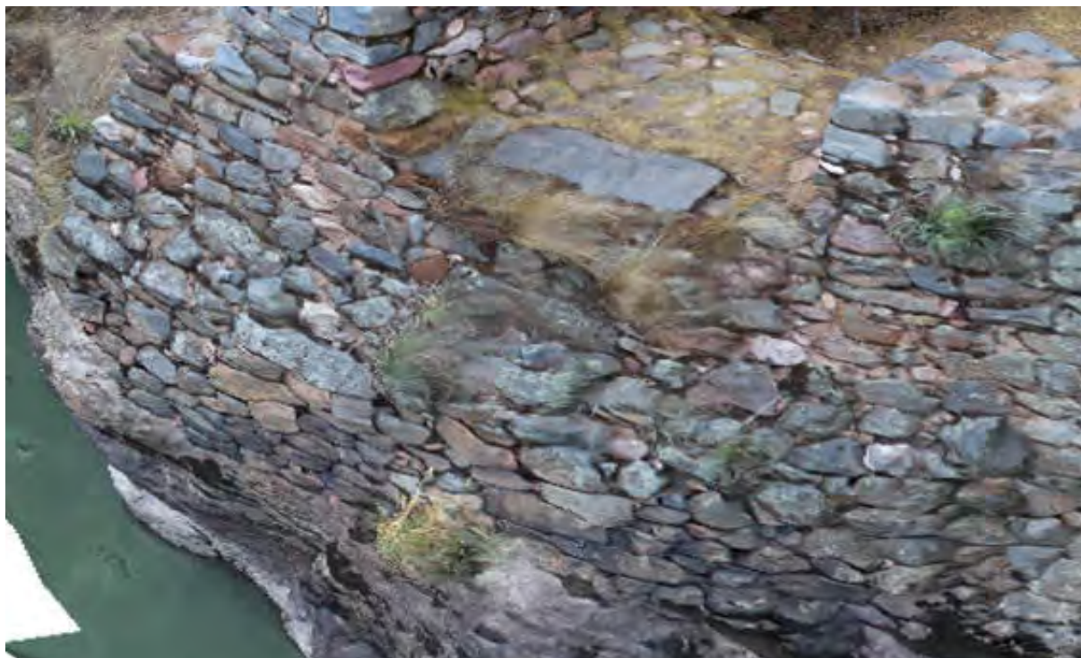
Figura 119. Contrapesos: elementos utilizados para equilibrar las fuerzas y reducir esfuerzos.
