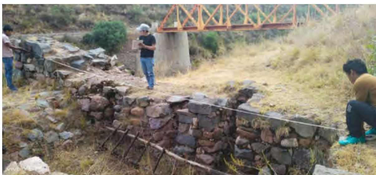
Figura 64. Registro gráfico y escrito de los estribos del puente.
