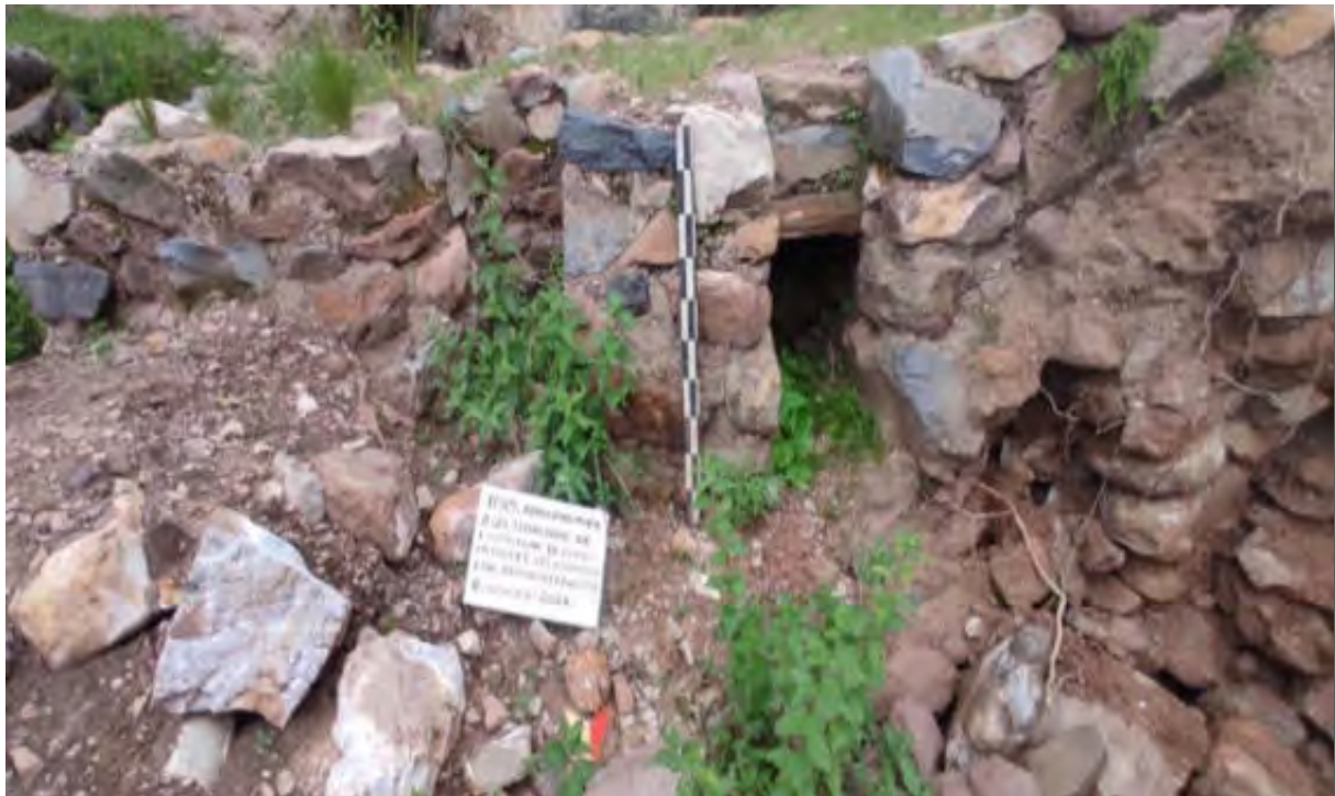
Figura 81. Muestra de uno de los contrafuertes del estribo izquierdo.
