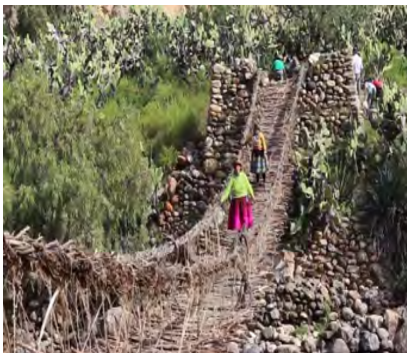
Figura 105. Usuarios del programa Pensión 65 reconstruyen el puente colgante de Sarhua.
