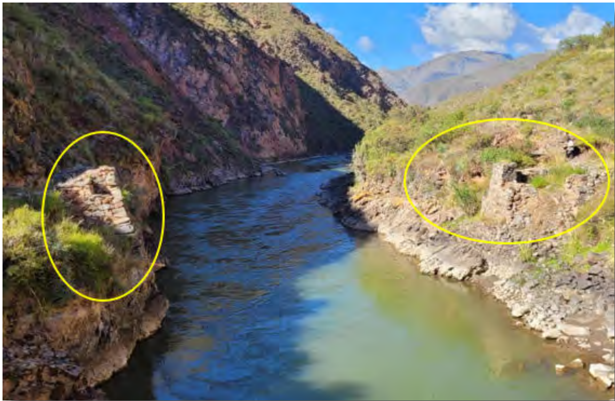
Figura 67. Registro de los dos estribos ubicados en ambos extremos del río Vilcanota.
