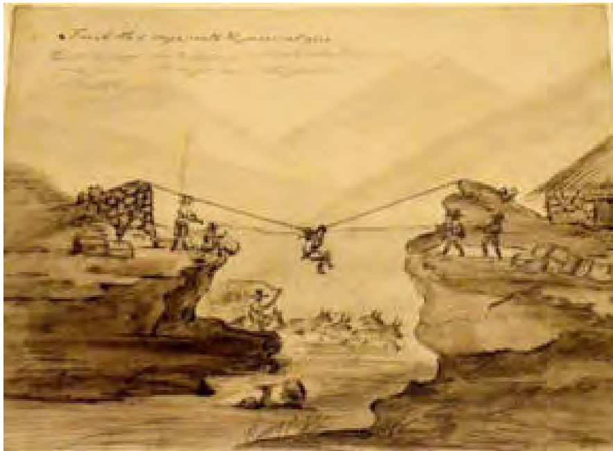
Figura 24. Puente de tipo oroya.
