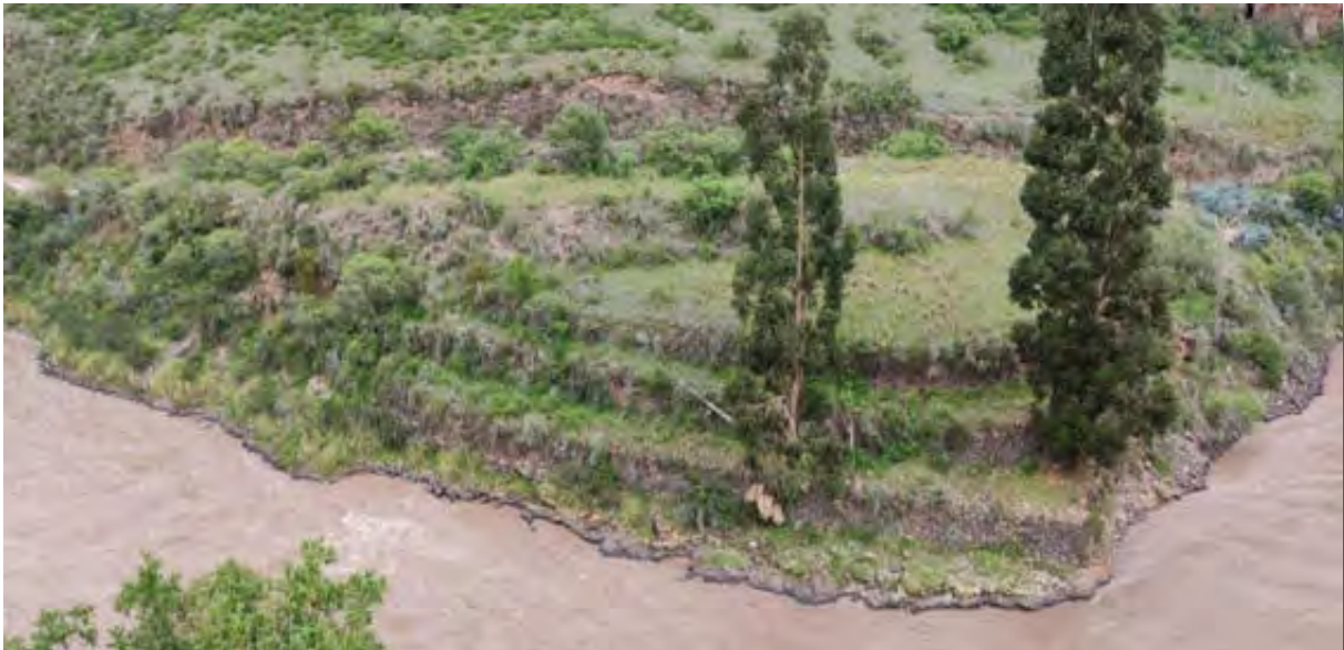
Figura 94. Estructura de contención y terrazas al borde del río.
