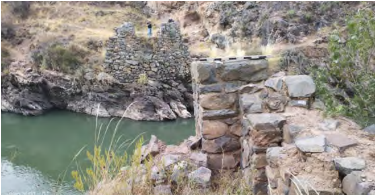
Figura 65. Muros a base de piedra con mortero de barro de los estribos.
