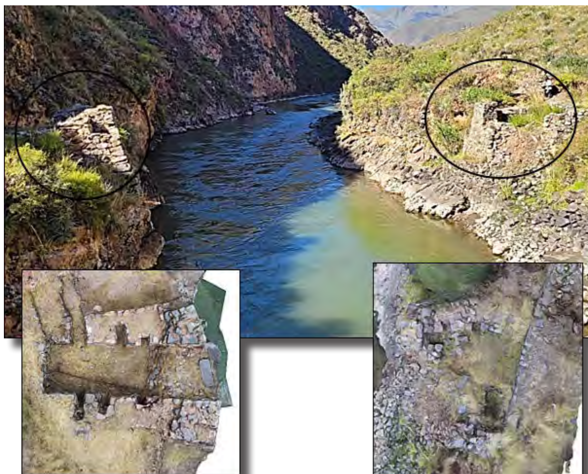
Figura 85. Estructuras de soporte del puente Yunkapunku: estribos.
