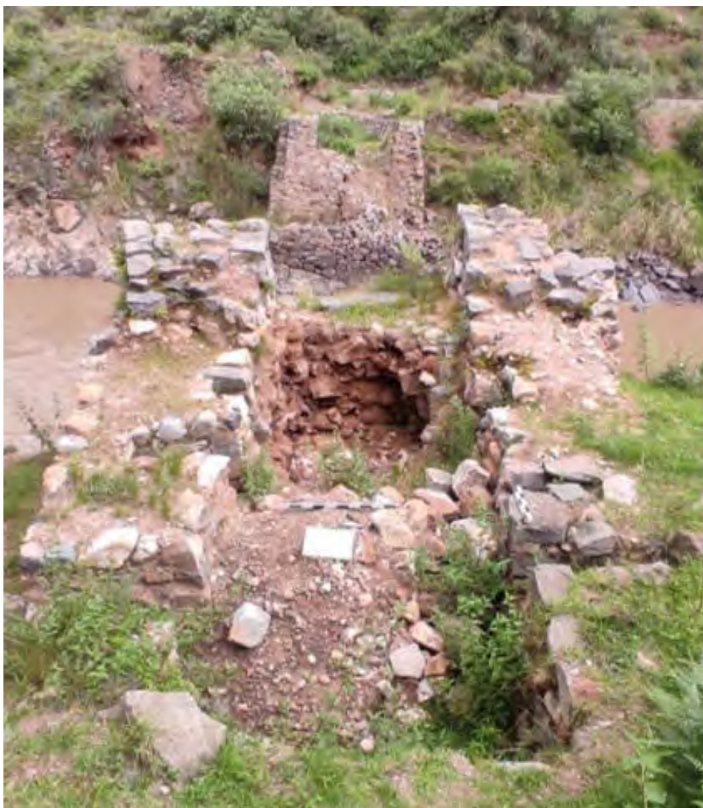
Figura 122. Muestra de los daños ocasionados por huaqueo en uno de los estribos.
