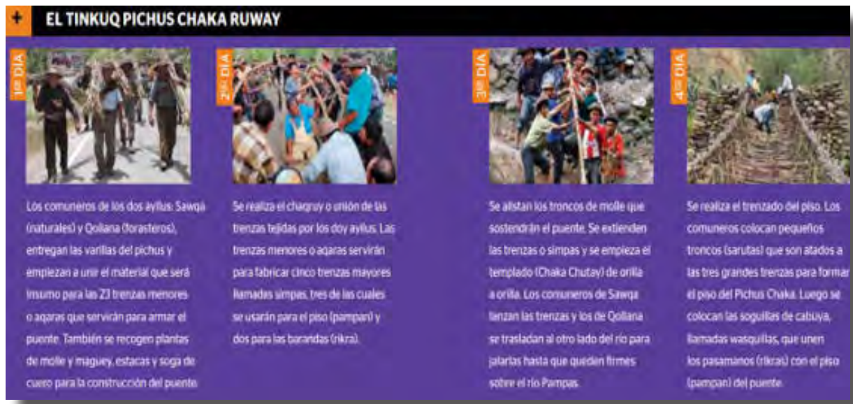
Figura 107. Proceso de construcción del puente de Sarhua.
