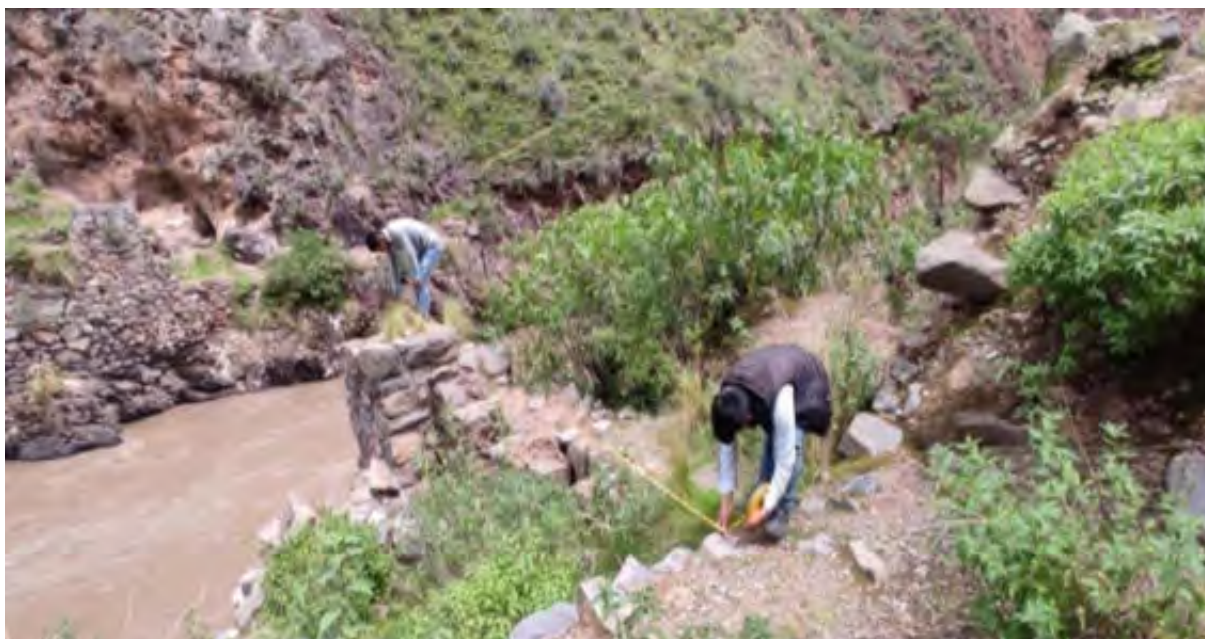
Figura 77. Trabajos de medición del estribo derecho, donde se muestra parcialmente su estructura.
