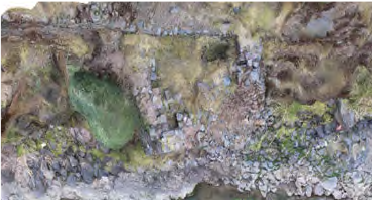
Figura 102. Vista en planta del estribo sur.
