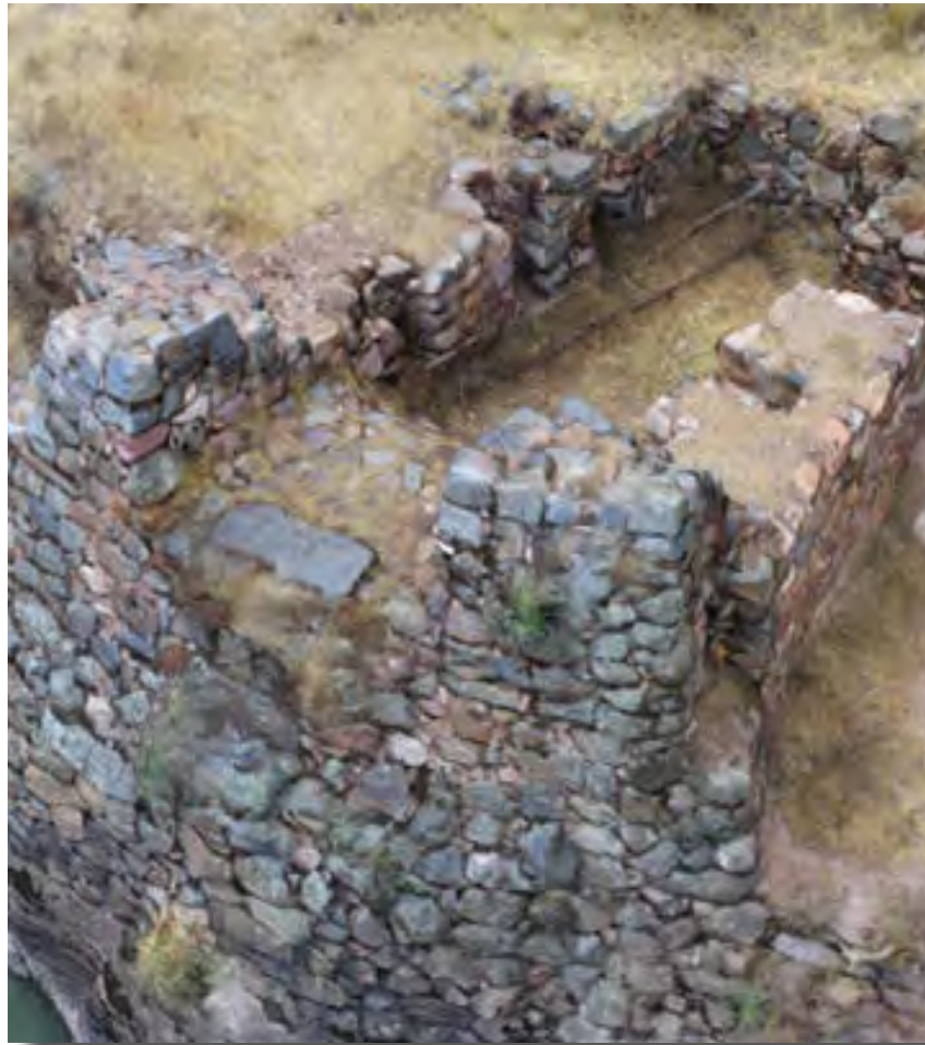
Figura 88. Vista oblicua de la estructura del estribo izquierdo.
