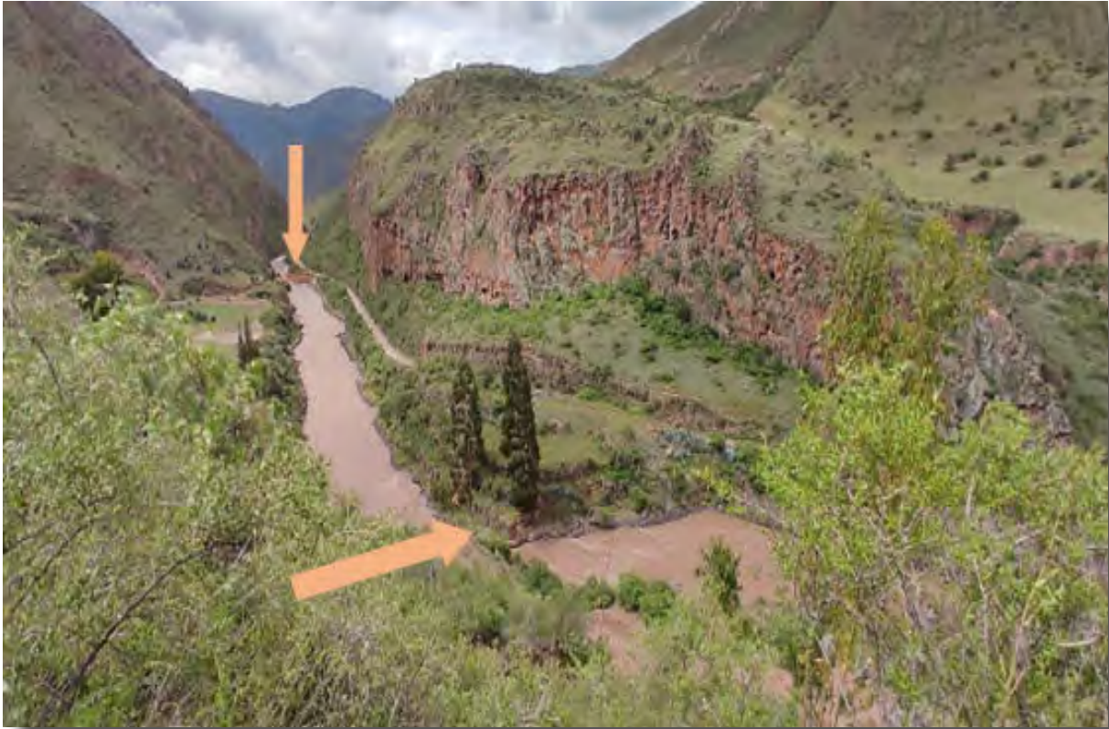
Figura 93. Muro de contención a la altura del estribo izquierdo.
