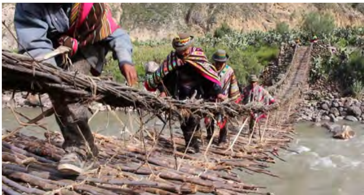
Figura 106. Reconstrucción del puente colgante de Sarhua.
