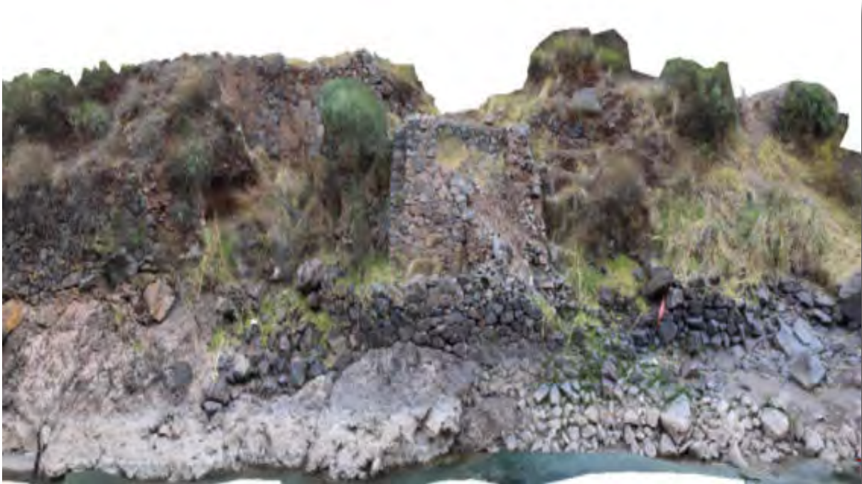
Figura 101. Vista frontal de los estribos.
