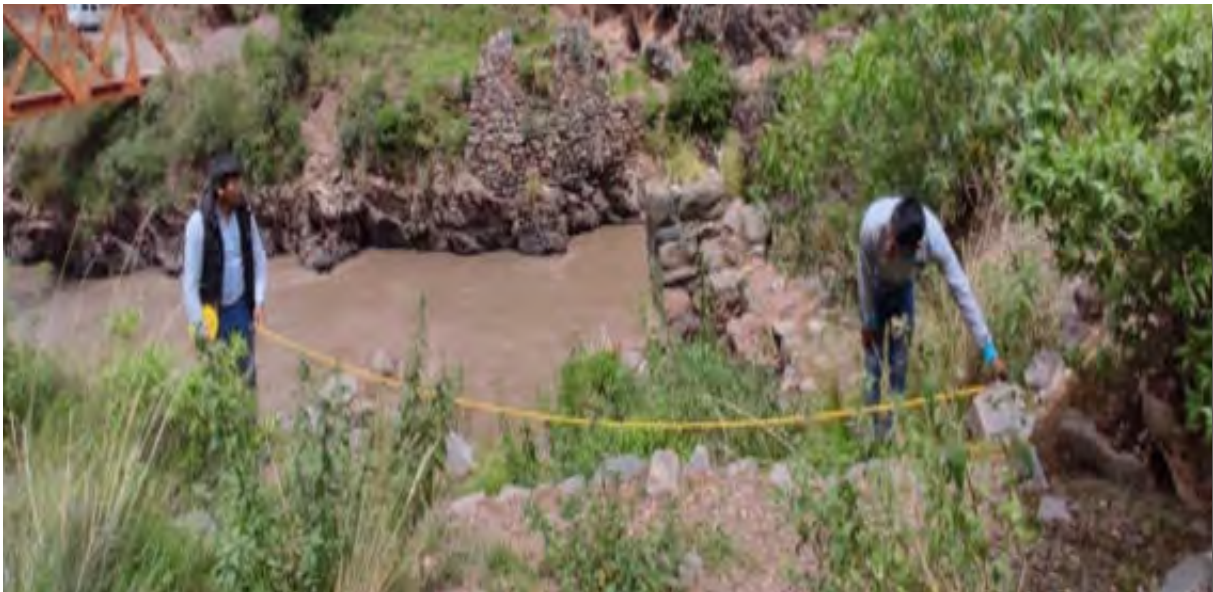
Figura 76. Trabajos de medición con wincha de los estribos de Yunkapunku.
