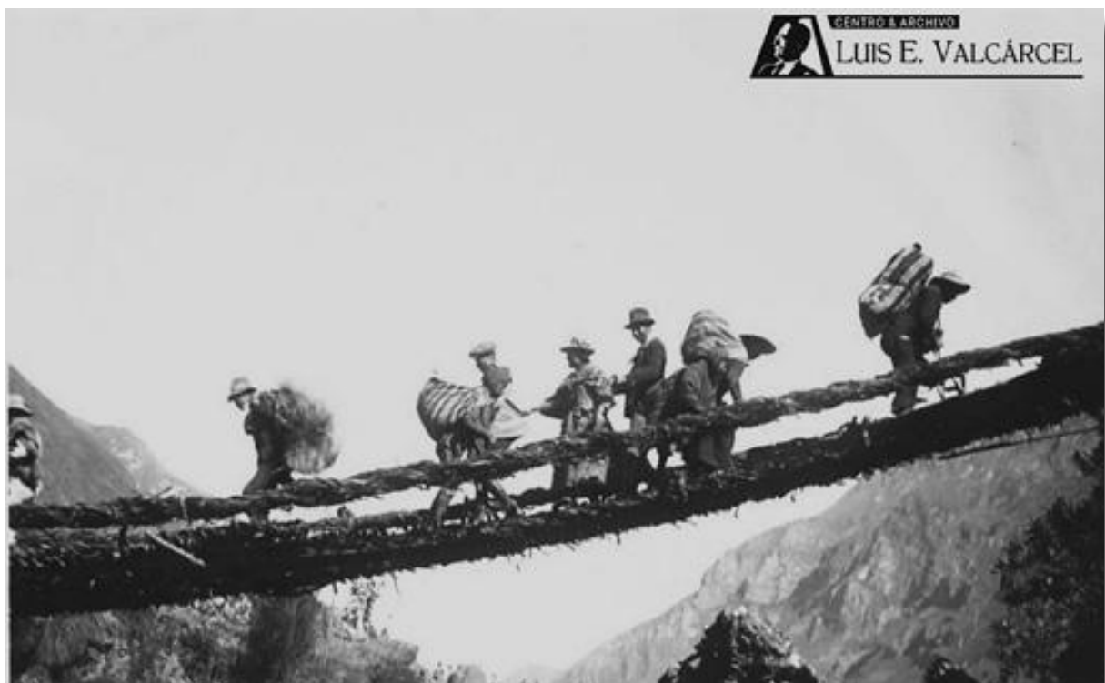
Figura 104. Utilización del puente colgante construido con material vegetal.
