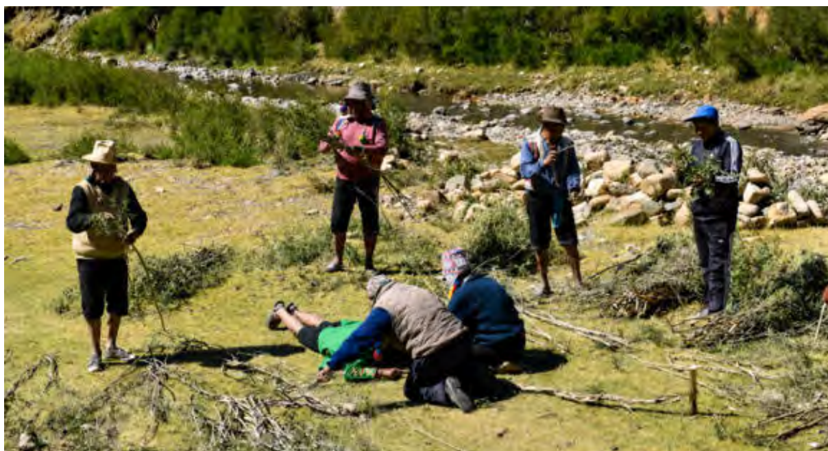
Figura 44. Inicio del trenzado de las chakas a base de material de lloq'e.
