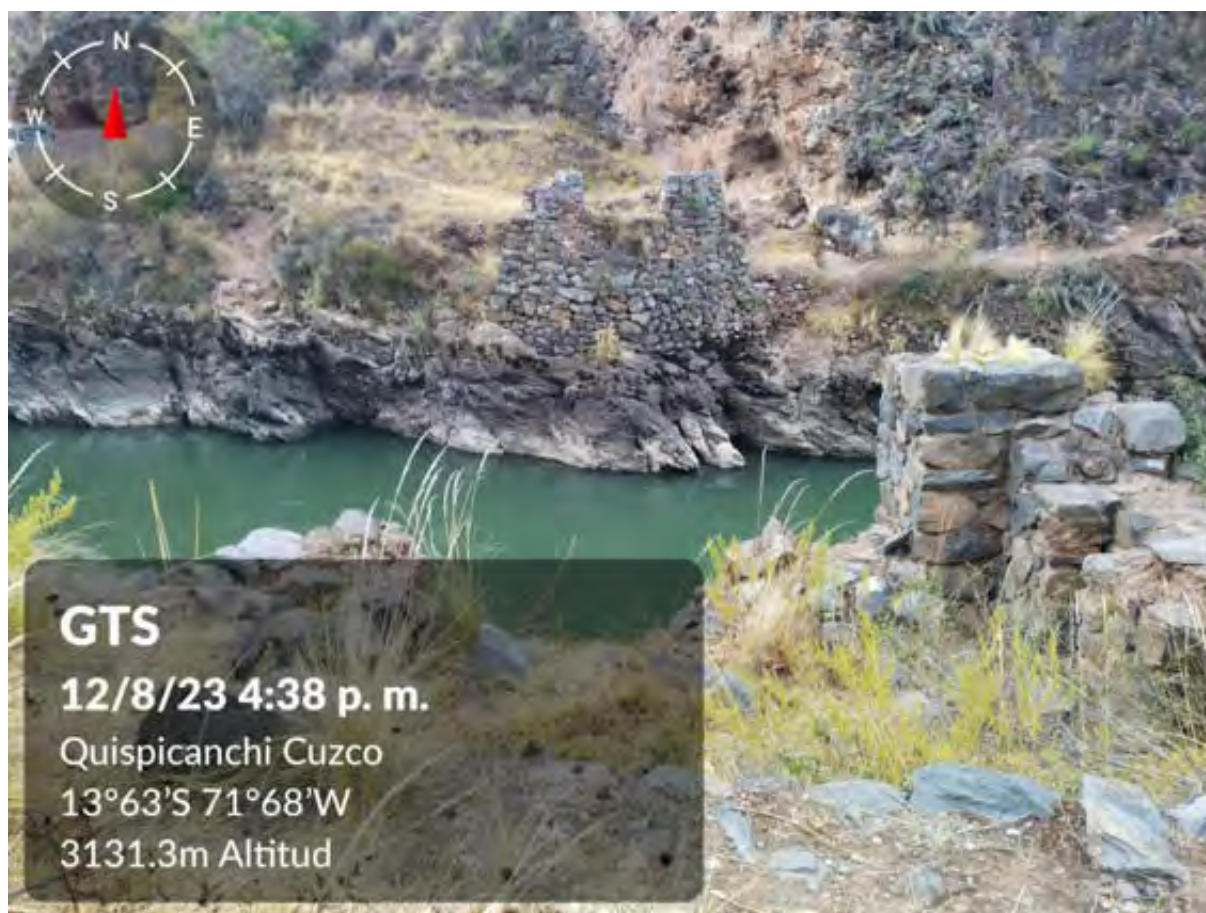
Figura 63. Estribos registrados del puente Yunkapunku.
