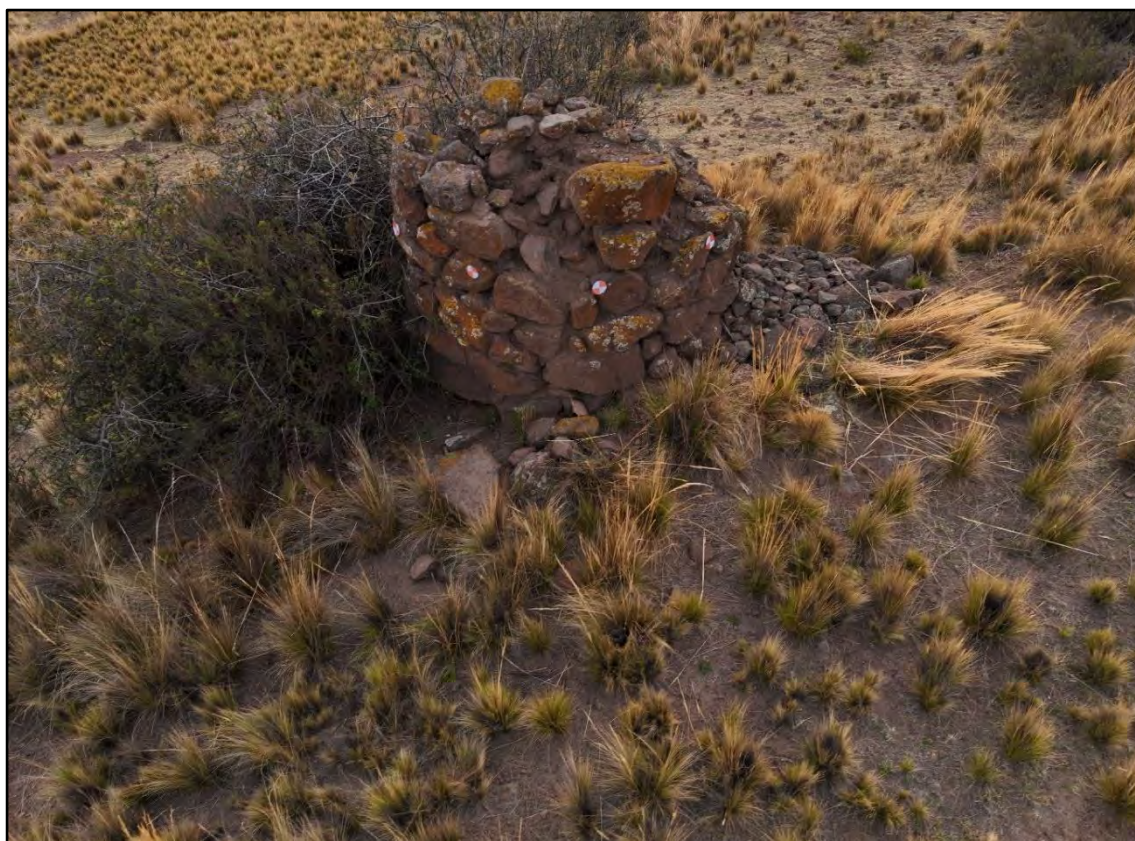
Elemento primario (Muro)
