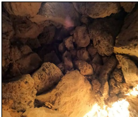
Elemento primario (Falsa bóveda)
