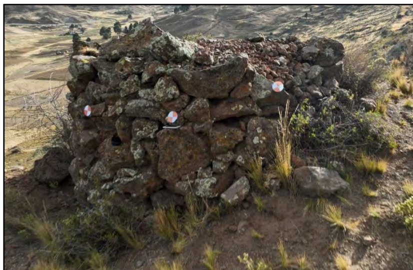
Elemento primario (Muro)
