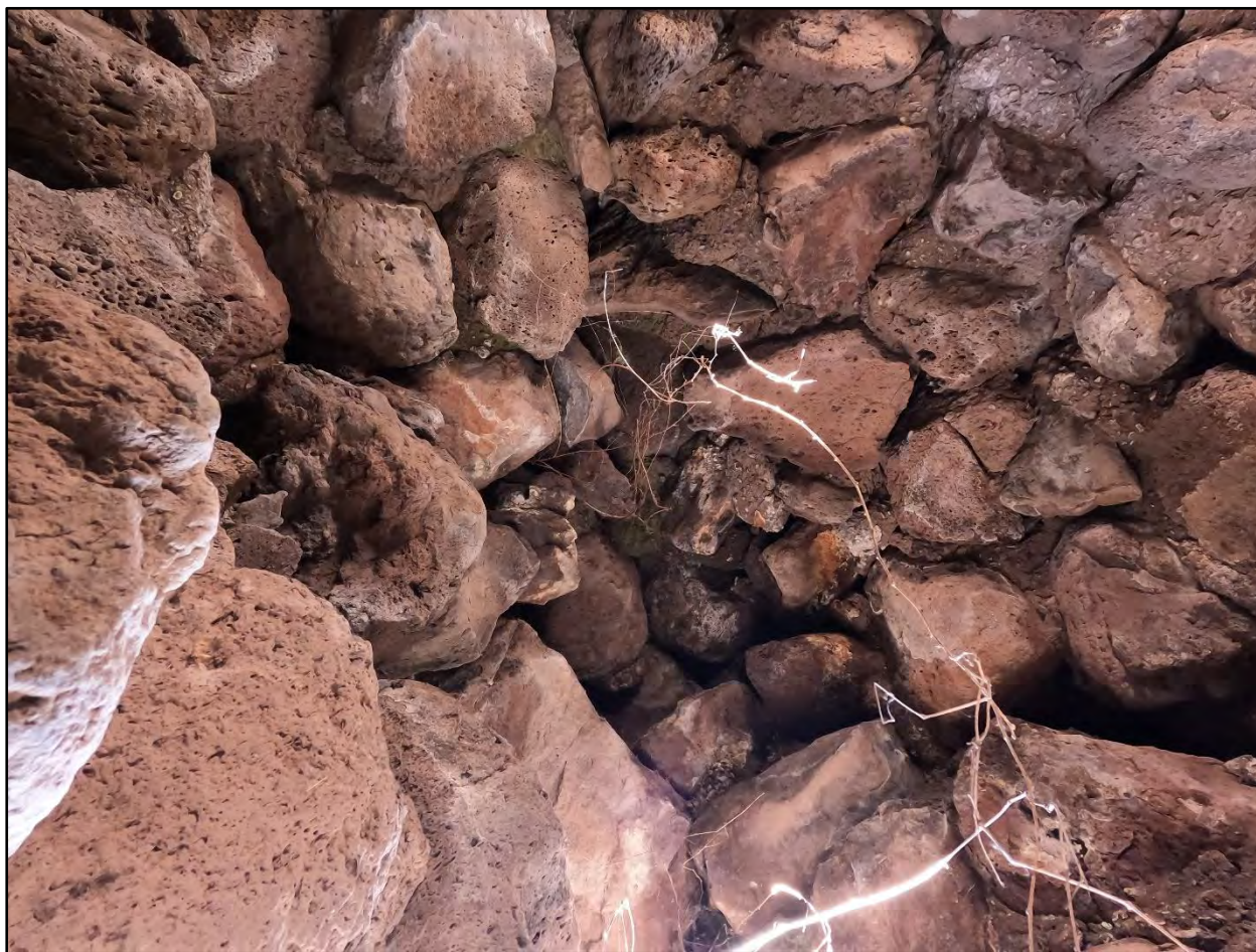
Elemento primario (Falsa bóveda)
