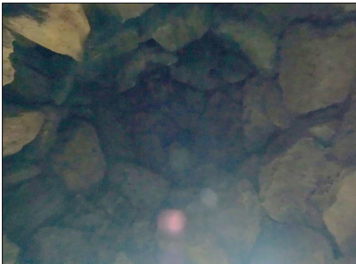
Elemento primario (Falsa bóveda)
