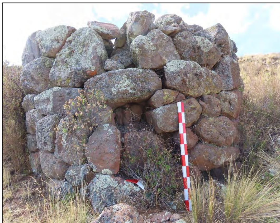
Elemento primario (Muro)
