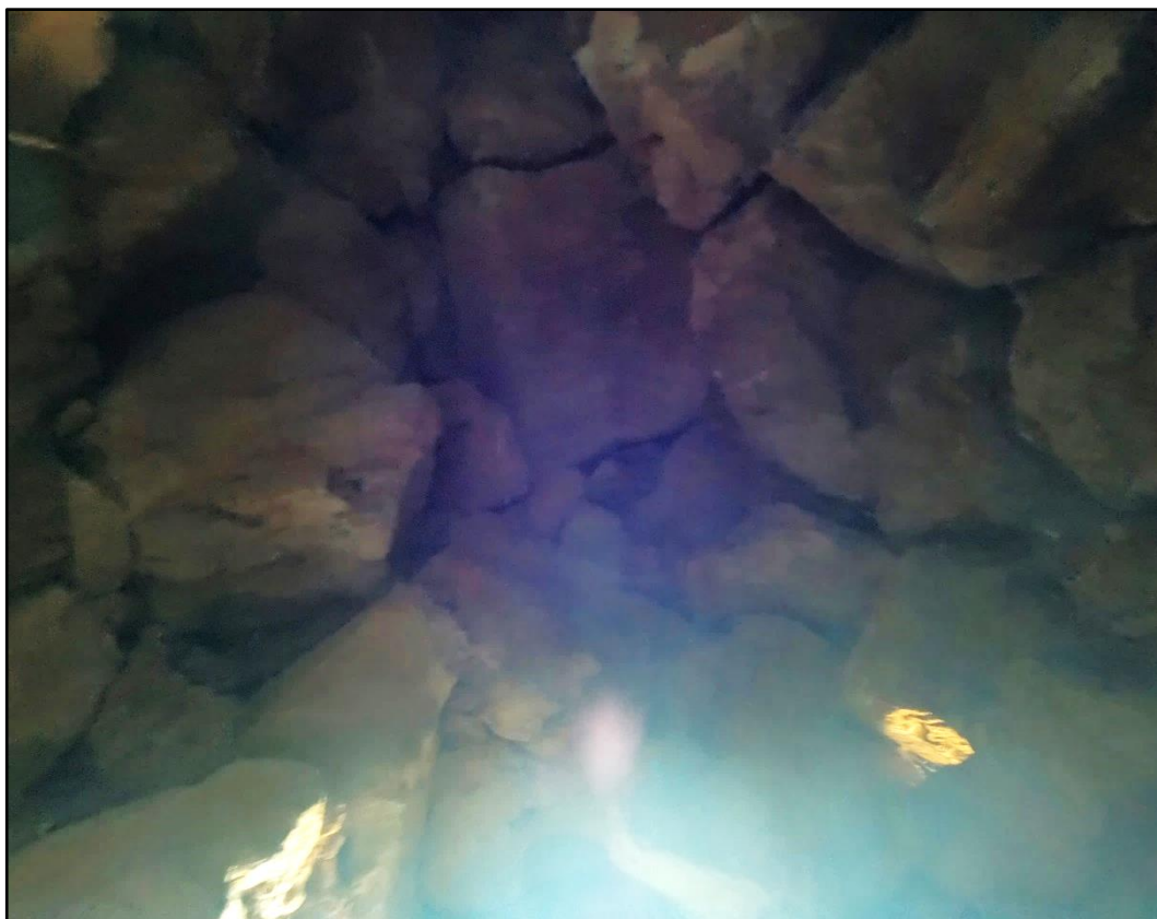
Elemento primario (Falsa bóveda)
