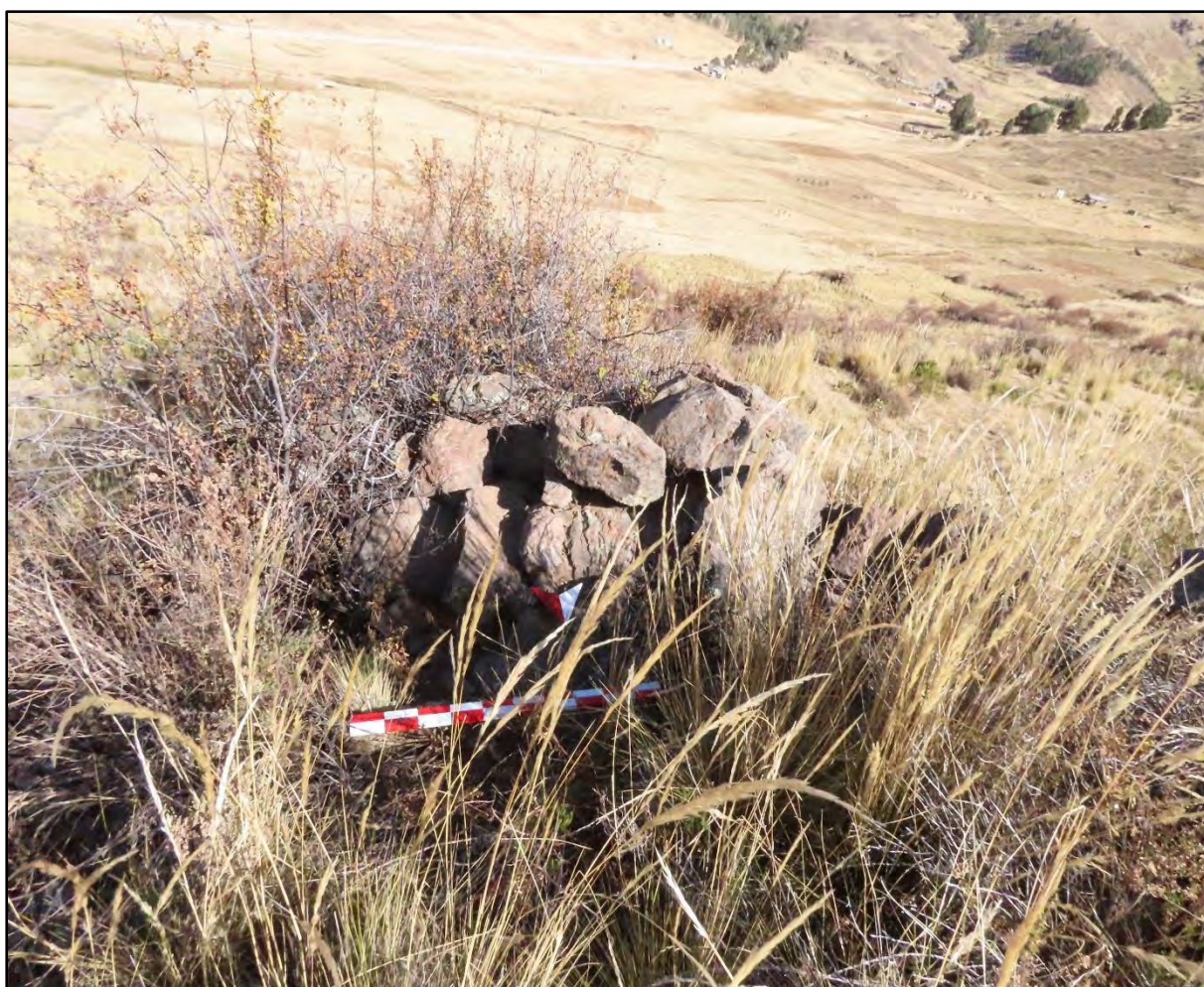
Elemento primario (Muro)
