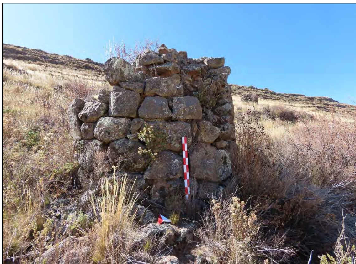
Elemento primario (Muro)
