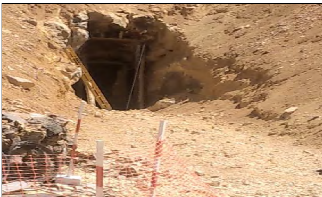
Fotografía N° 08: Sostenimiento en bocamina antes del vaciado con concreto.
