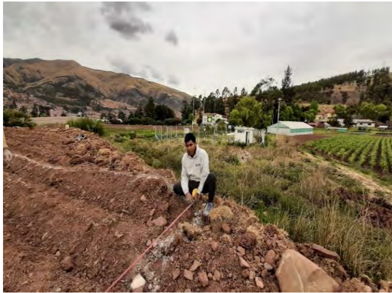
Fotografía 7. Trazado con yeso agrícola
