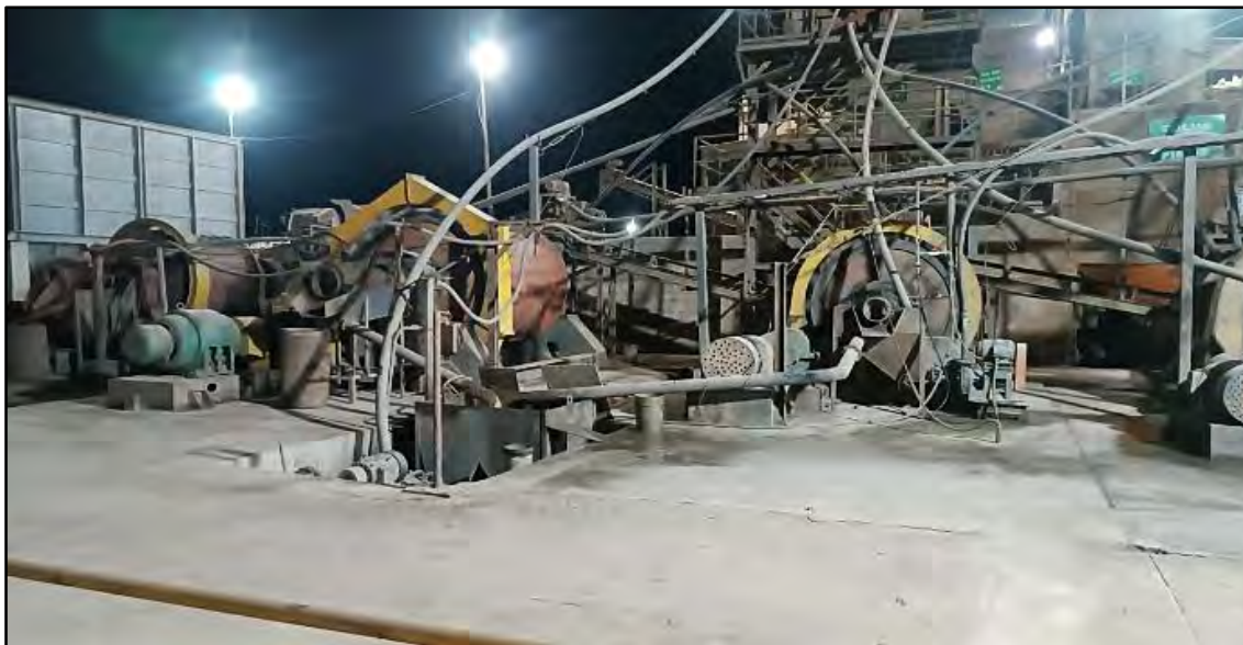
Foto 1 Circuito de molienda en operación
