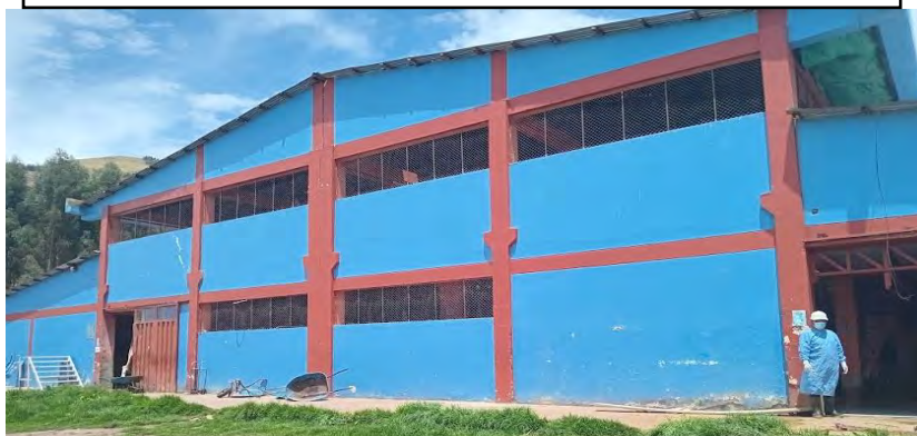
Puerta principal de ingreso al camal municipal
