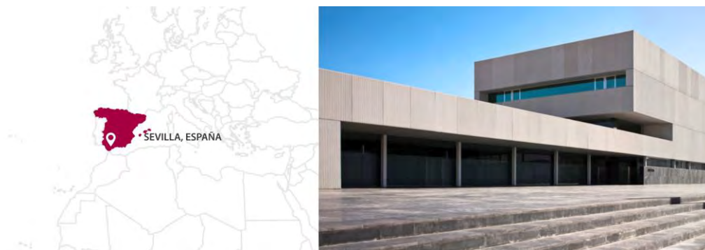
Ilustración 48: Ingreso del Edificio Juzgados, Morón de la Frontera, España
