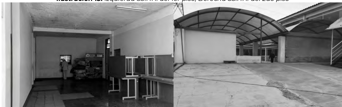
Ilustración 13: Izquierda SS.HH. del 1er piso, Derecha SS.HH. del 2do piso
