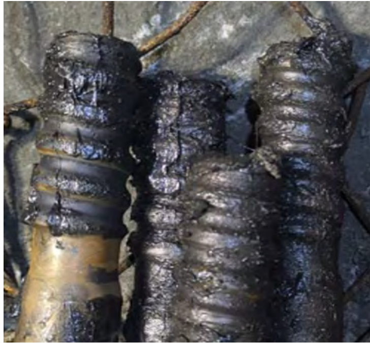
Figura 55: Rotación adecuada de barras I
