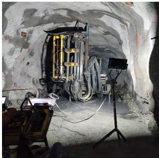
Figura 86: Perforación de taladros largos simba N°19
