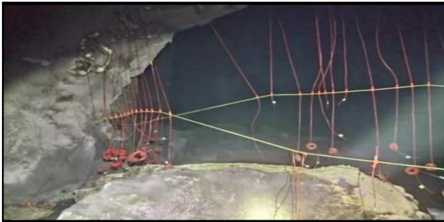
Figura 89: Sección de Taladros Positivos Cargados
