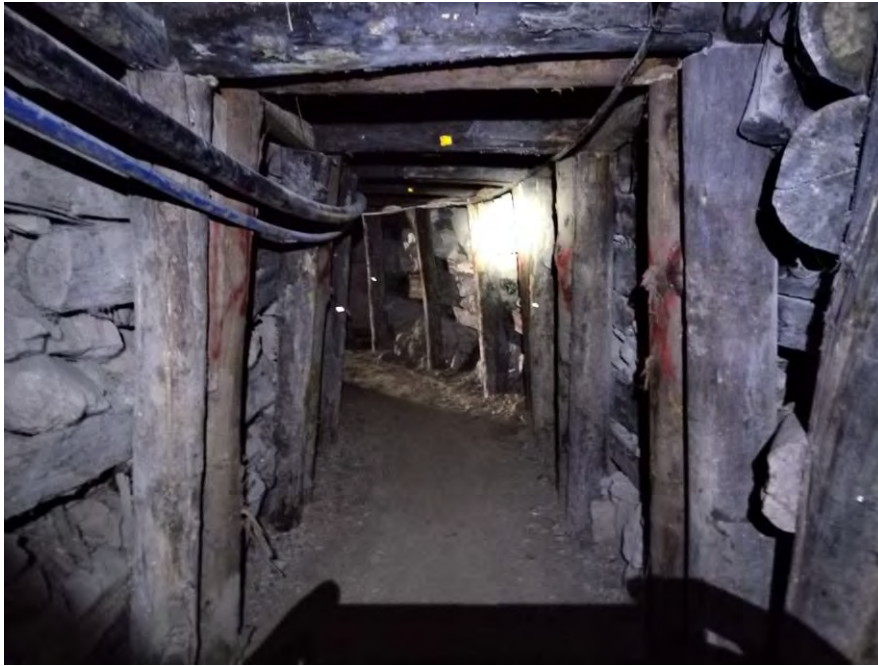
Imagen 6: Sostenimiento de galería con cuadros de madera
