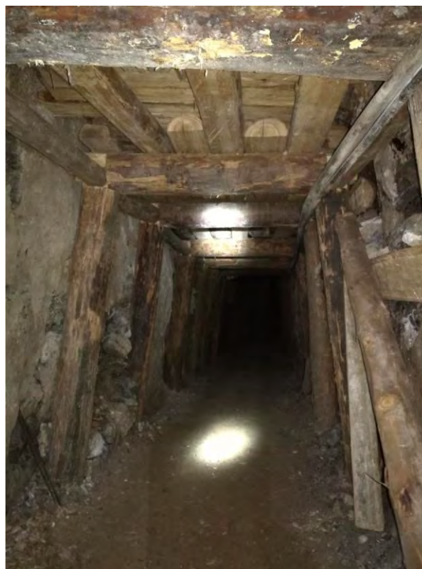
Imagen 12: Cuadro completo de madera Mina Patay Uno
