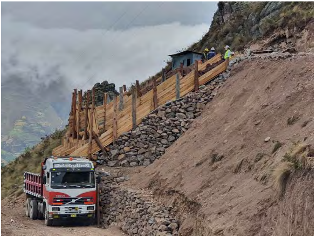
Imagen 30: Acumulación de mineral en la tolva san Lorenzo.
