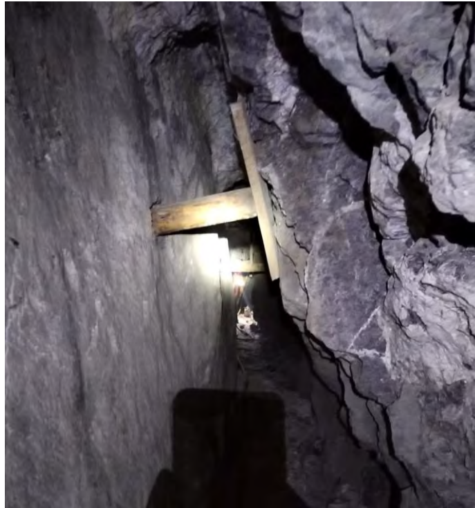
Imagen 19: Puntal de seguridad en tajo.
