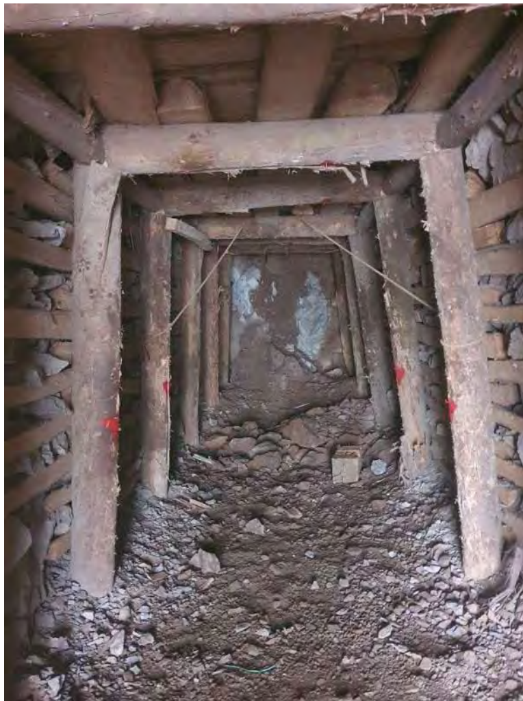
Imagen 29: Sostenimiento con cuadros de madera.
