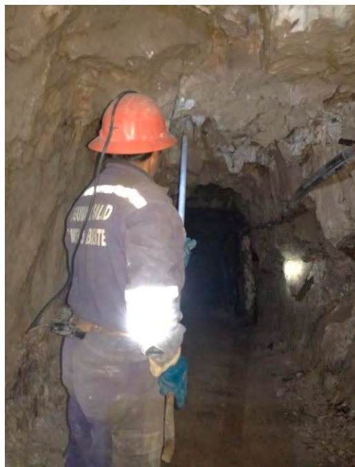
Imagen 7: Personal realizando el desatado de rocas
