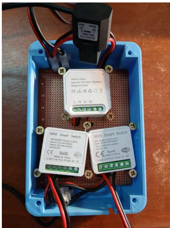
Anexo 13: Proceso de conexionado eléctrico en el medidor inteligente
