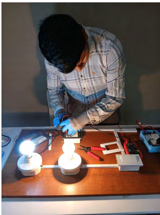
Anexo 19: Proceso de pruebas de funcionamiento de instalaciones en el módulo experimental
