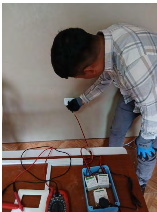
Anexo 18: Proceso de energización del módulo experimental
