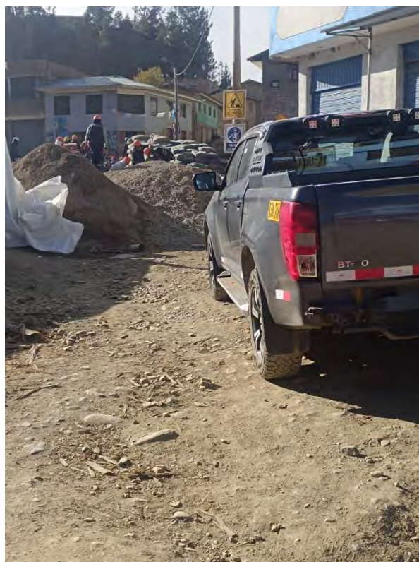
Nota: construcción de puente en la comunidad de Tinki que lleva a la comunidad de Pacchanta
