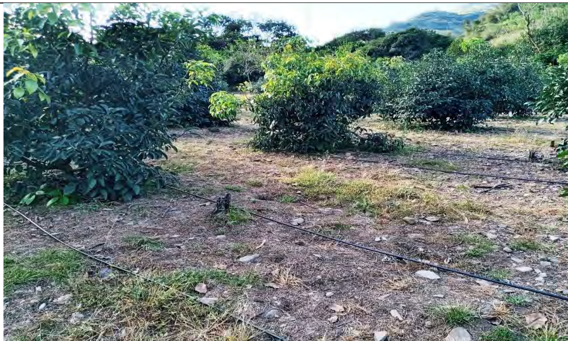
Fotografía 24. Mangueras de 16mm instaladas por los 2 extremos de la planta
