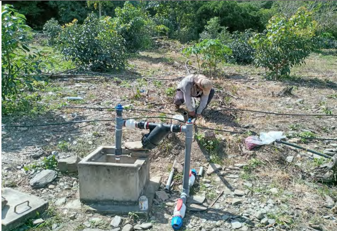
Fotografía 23. Instalación de porta laterales a la matriz principal
