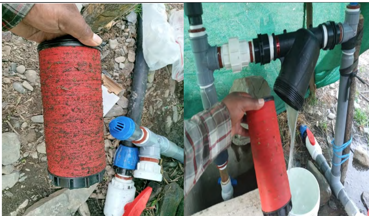
Fotografía 27. Lavado de filtro de riego, para el normal desempeño del sistema de riego.
