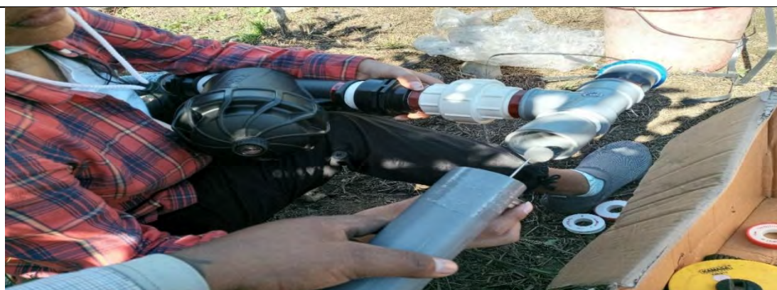
Fotografía 15. Armado de cabezal de riego
