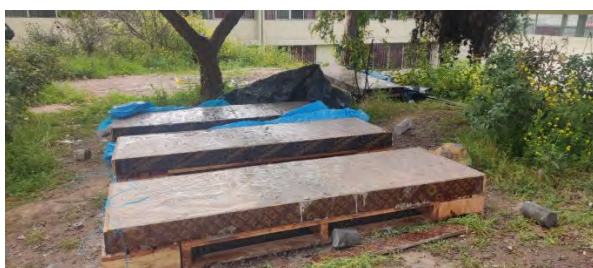
Figura 30: Curado de Losas LM-01, LM-02, LM-03, LM-04 día 4
