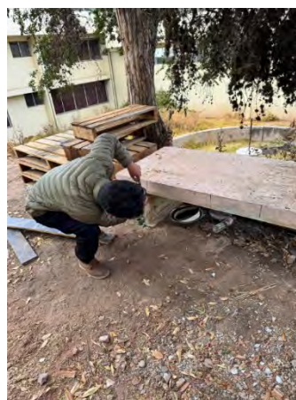
Figura 66: Toma de datos de las deflexiones diferidas de la losa maciza LM-04, día (18/07/25)
