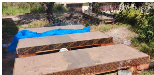
Figura 35: Curado de Losas LM-01, LM-02, LM-03, LM-04 día 21
