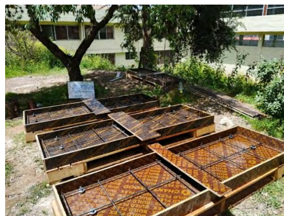
Figura 21: Colocación de armado de acero en el encofrado para losas macizas
