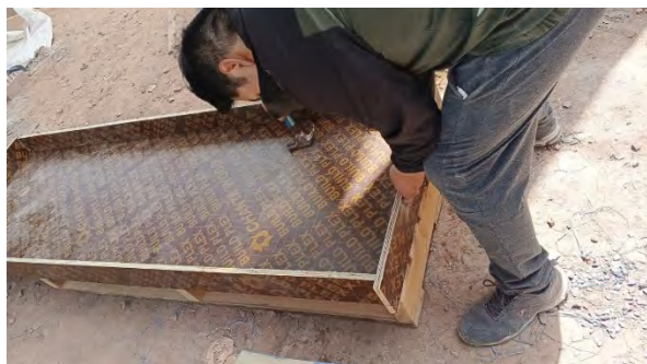
Figura 18: Vista general del proceso de armado del encofrado con fenólico sobre parihuelas para la losa maciza.
