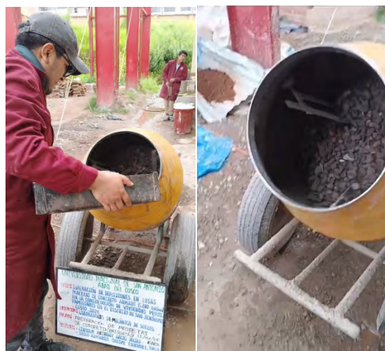
Figura 12: Elaboración de la mezcla de concreto f'c 280 kgf/cm 2 en trompo de
