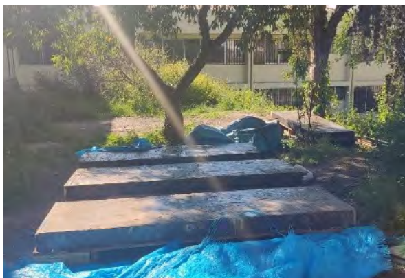
Figura 22: Vaciado de Losas de concreto armado f'c 280 kgf/cm 2 LM-01, LM-02, LM-03, LM-04
