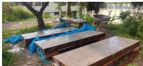
Figura 31: Curado de Losas LM-01, LM-02, LM-03, LM-04 día 7
