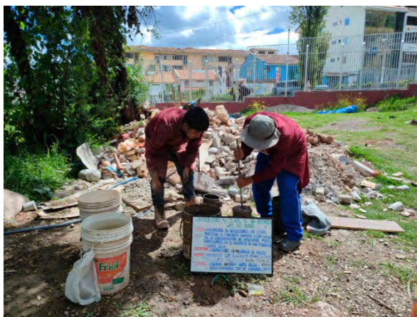
Figura 24: Preparación de briquetas de control del vaciado de la mezcla de concreto f'c 280 kgf/cm 2
