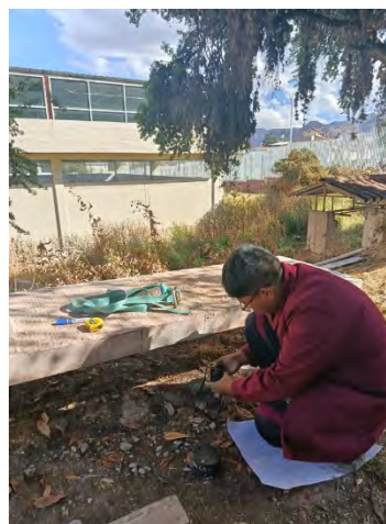
Figura 64: Toma de datos de las deflexiones inmediatas de la losa maciza LM-04 (25/06/25)
