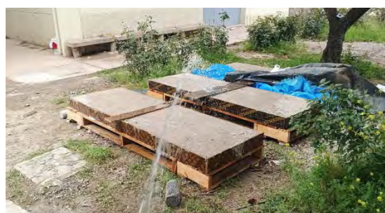
Figura 27: Curado de Losas LM-01, LM-02, LM-03, LM-04 día 1
