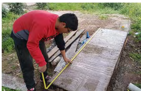
Figura 28: Verificación de medidas de Losas LM-01, LM-02, LM-03, LM-04
