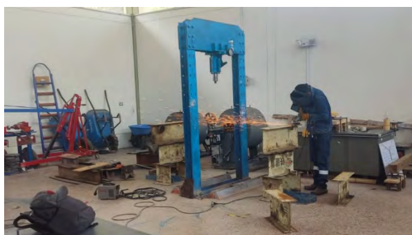
Figura 38: Armado y soldado de soportes de perfil metálico tipo H
