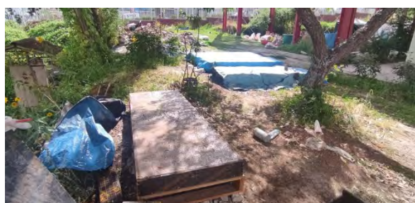
Figura 34: Curado de Losas LM-01, LM-02, LM-03, LM-04 día 20
