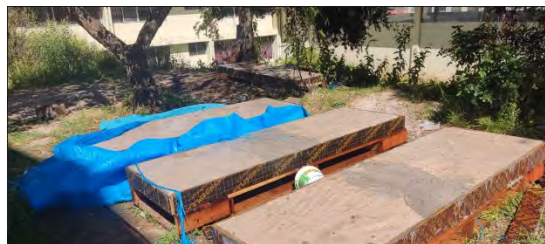
Figura 33: Curado de Losas LM-01, LM-02, LM-03, LM-04 día 19
