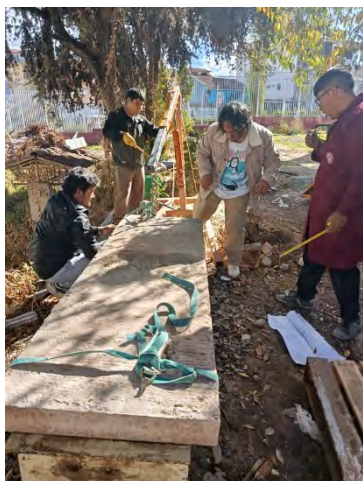
Figura 63: Izamiento de losa LM-04 para su ensayo
