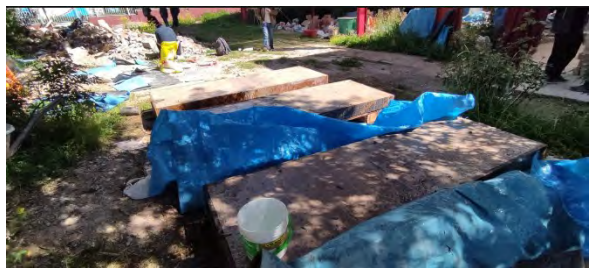
Figura 32: Curado de Losas LM-01, LM-02, LM-03, LM-04 día 11
