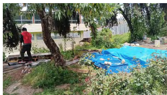
Figura 29: Curado de Losas LM-01, LM-02, LM-03, LM-04 día 2
