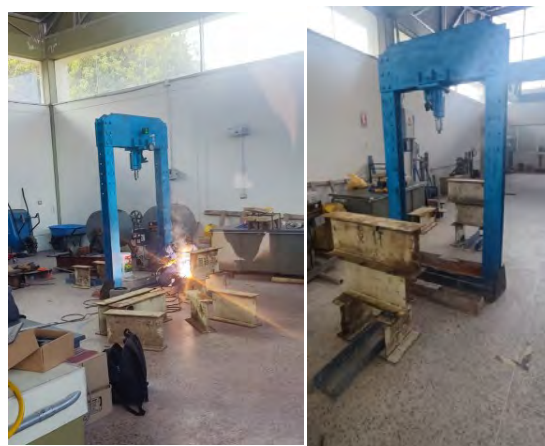
Figura 39: Posicionamiento de soportes de perfil metálico tipo H
