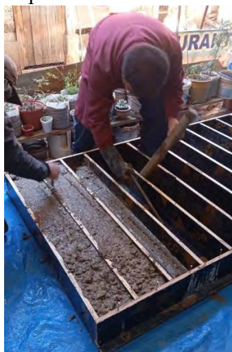
Fotografía 23. Elaboración de vigas de concreto, con acero embebido
