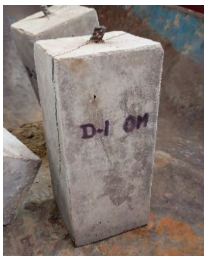
Fotografía 53. Efecto del ensayo de adherencia para D1-OM
