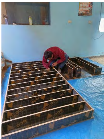
Fotografía 27. Colocación de los aceros corroídos y no corroídos en las vigas
