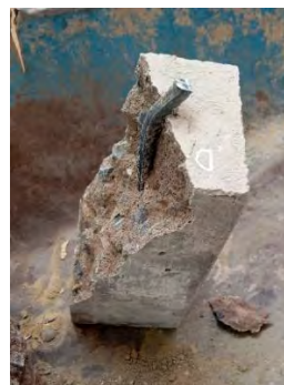
Fotografía 52. Efecto del ensayo de adherencia para D3-OP
