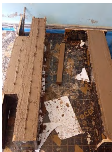
Fotografía 24. Elaboración de dados de concreto con acero embebido
