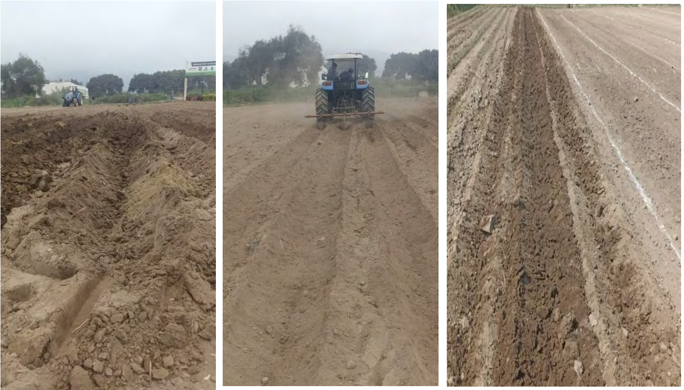
Fotografía N° 7. Preparación del terreno
