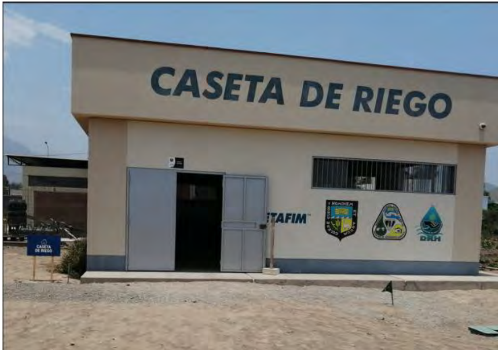
Foto 18. Caseta de riego, CIER – UNALM
