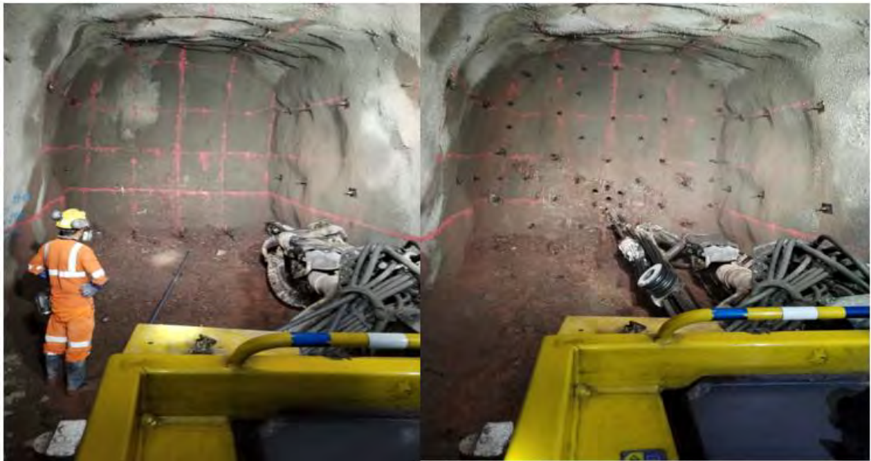
Figura 18 Control de paralelismo y uso de guidores
