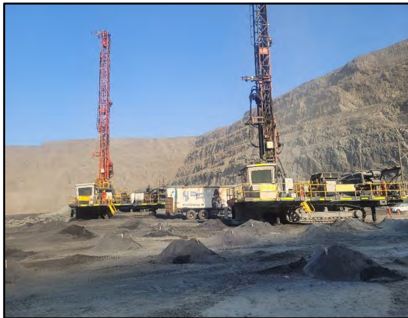
Figura 21. Equipos De Perforación de Diámetro 11''
