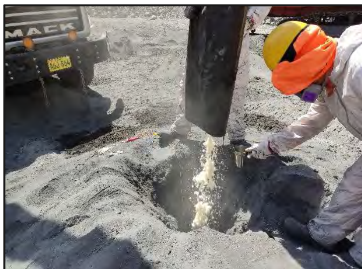
Figura 29. Dentro del cargado de explosivo se realiza el control de densidades
