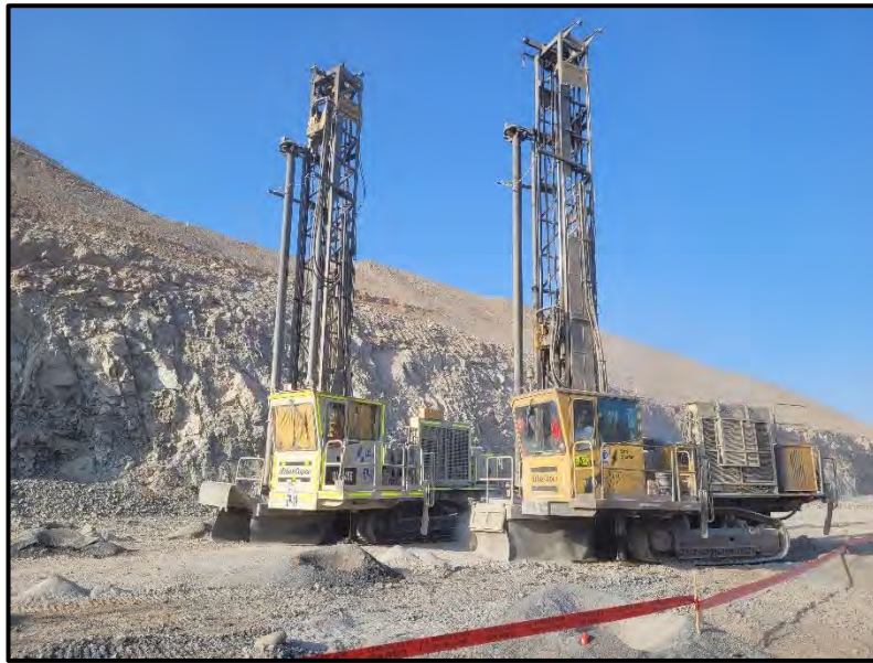
Figura 20. Equipos De Perforación de Diámetro 9''
