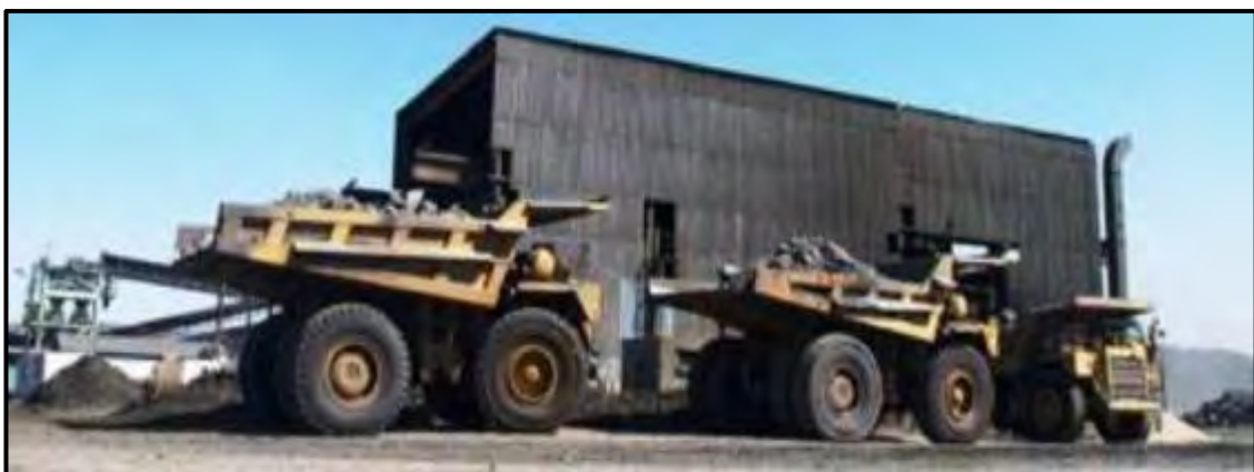
Figura 47. Zona de Chancado Planta 2, Shougang Hierro Peru
