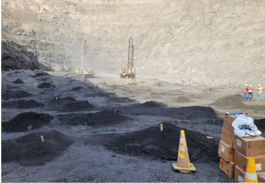
Figura 23. Plataforma zona mineral ya perforada, malla triangular.
