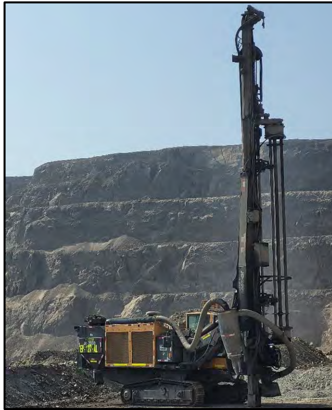
Figura 46. Perforadora JUNJIN de 5'' de diametro
