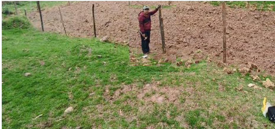
Fotografía N° 20: Colocado del cerco de postes
