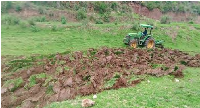
Fotografía N° 02 Preparación del terreno.
