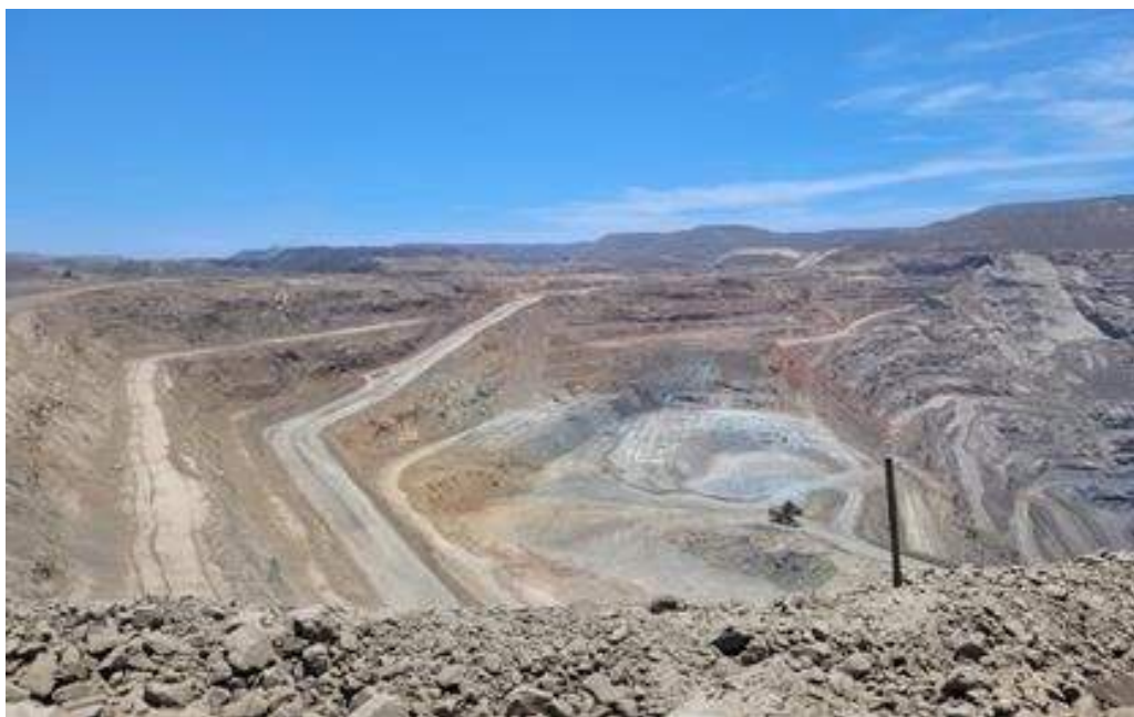
Figura 11: Taludes de Mina 5
