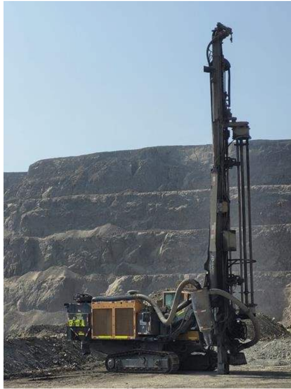
Figura 3: Perforadora Rockdrill, diametro de 5" taladros pre-corte
