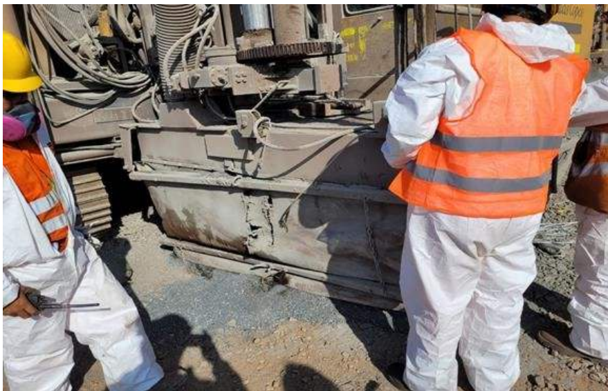
Figura 17: Mantenimiento a la perforadora
