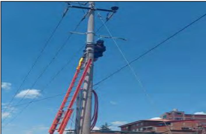
Figura 73 Montaje de seccionador de derivación tipo PSEC-3P
