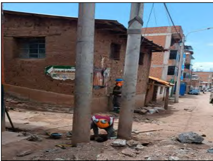
Figura 69 Retiro de poste de concreto armado antiguos
