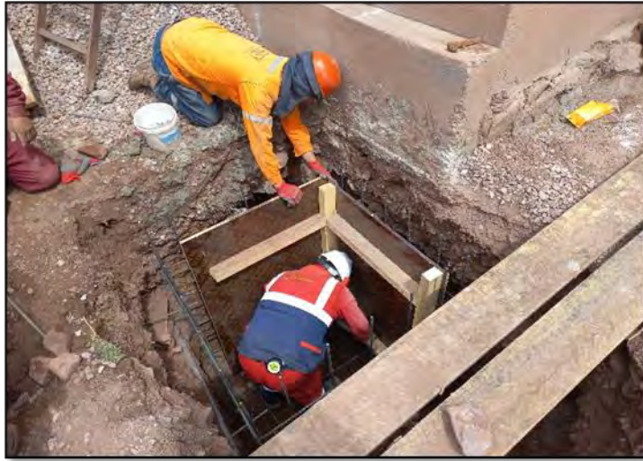
Figura 62 Encofrado de buzones de baja tensión
