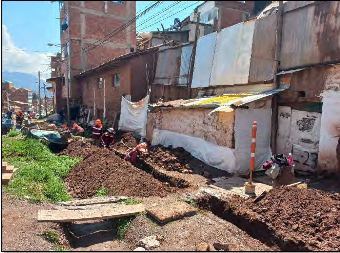
Figura 61 Excavación manual de zanja
