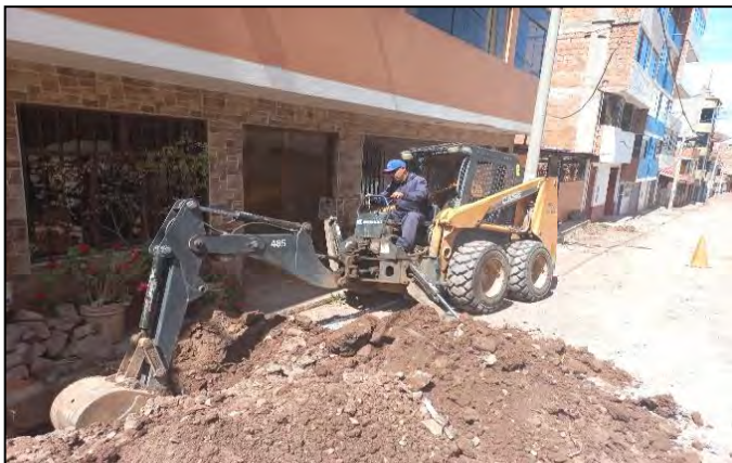
Figura 60 Excavación de zanja con maquinaria
