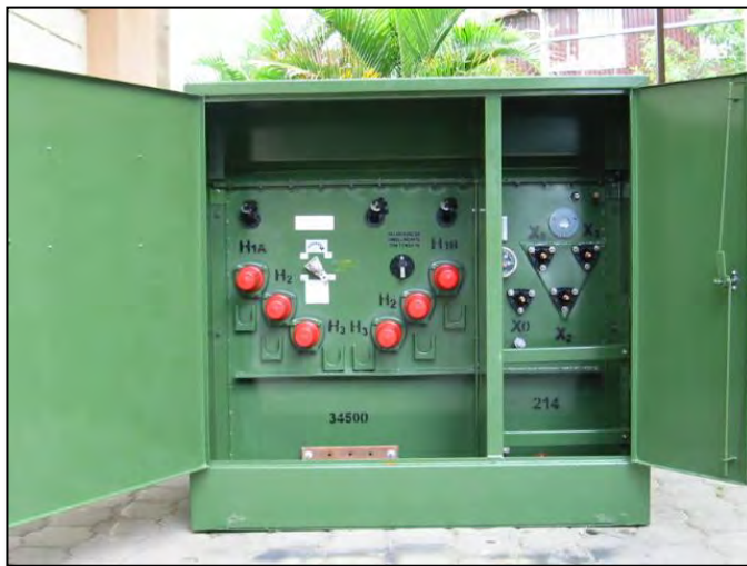
Figura 52 Transformador compacto-tipo pedestal
