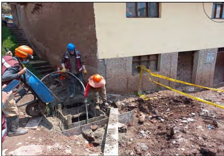
Figura 63 Vaciado de buzones de baja tensión
