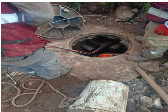
Figura 64 Tendido de conductor subterráneo de baja tensión
