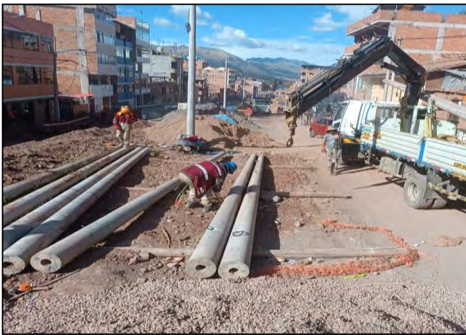
Figura 65 Traslado de postes de concreto de baja tensión a punto de izaje
