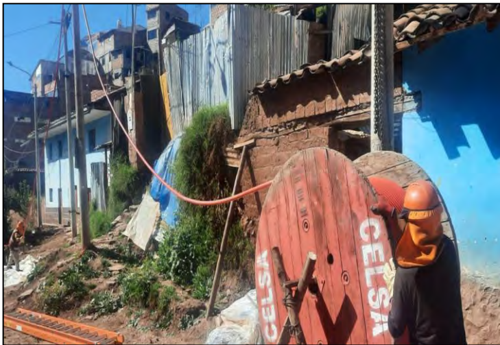
Figura 72 Tendido de conductor subterráneo tipo N2XSY de 50 mm 2 para redes de media tensión
