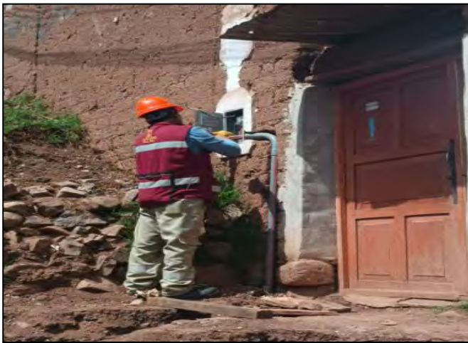
Figura 70 Montaje de acometidas domiciliarias
