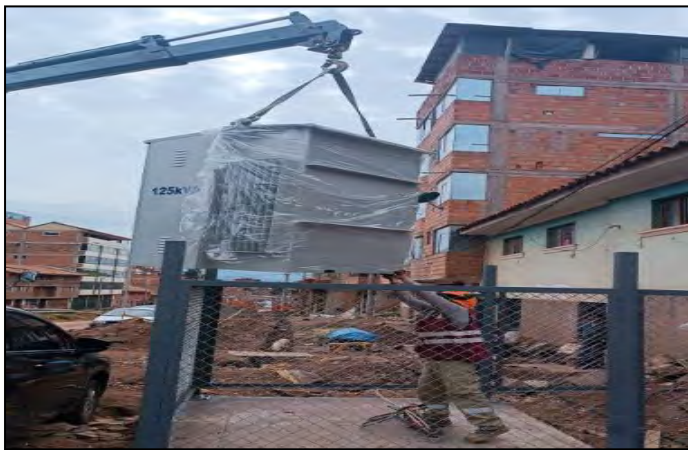
Figura 74 Montaje de subestación tipo pedestal, construcción de base para transformador y malla
