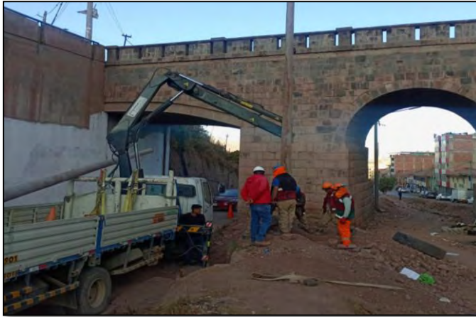
Figura 66 Izaje de poste de concreto de baja tensión
