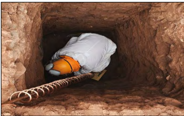
Figura 67 Colocación de varilla de cobre 3/4 pulgadas para elaboración de pozo a tierra
