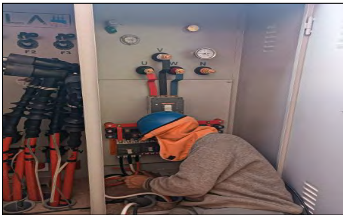
Figura 75 Montaje de terminales de media y baja tensión en el tablero del transformador
