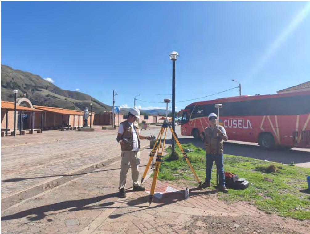
FOTOGRAFIA N°2: Instalación del GPS Diferencial para que trabaje en modo PPK
