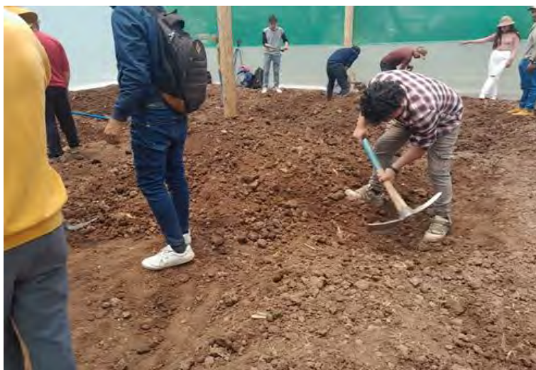
Nivelación del terreno
