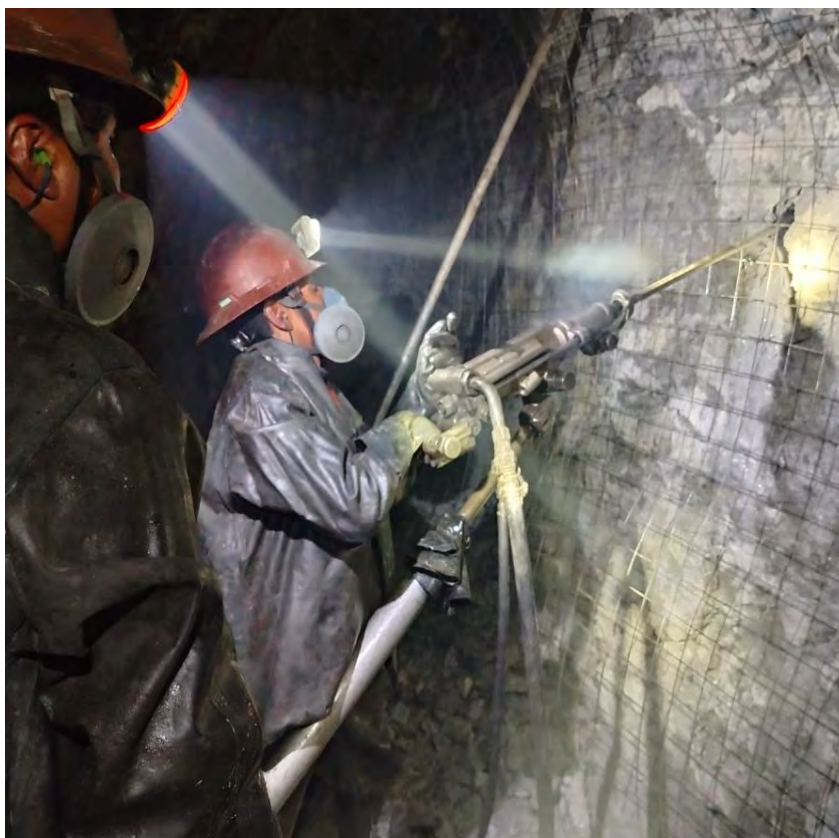
Figura 26 Etapa de sostenimiento del Crucero A-8 Norte.
