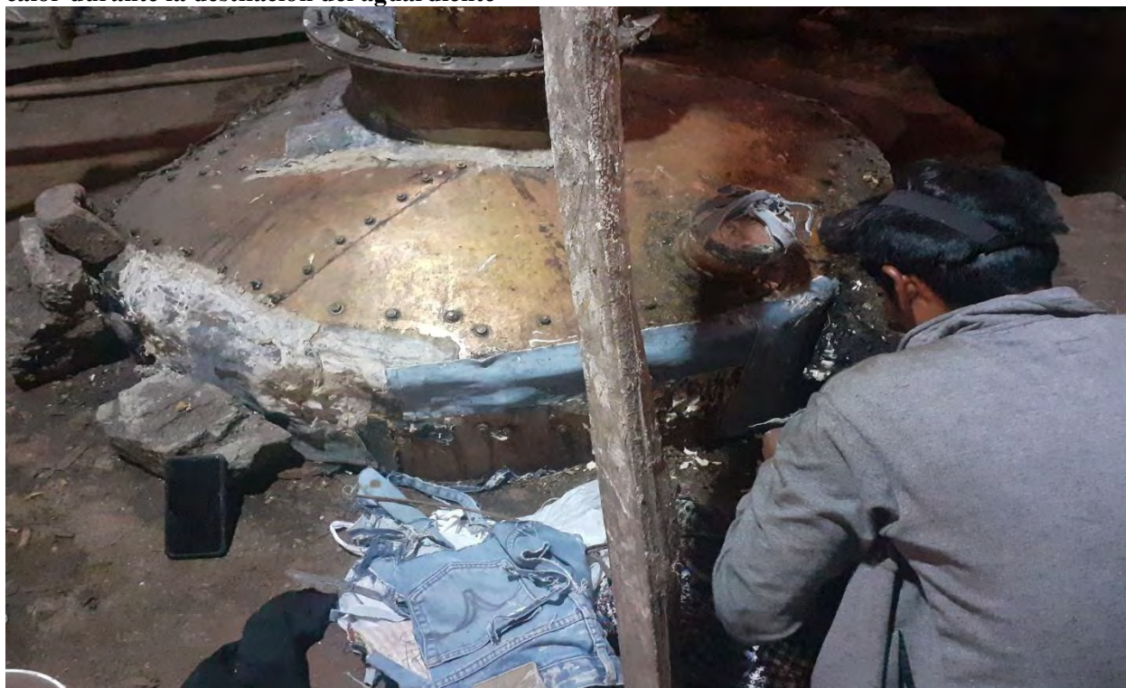
Fotografía N°-20: Momento en que se realiza el mantenimiento de la falca para evitar la fuga de calor durante la destilación del aguardiente
