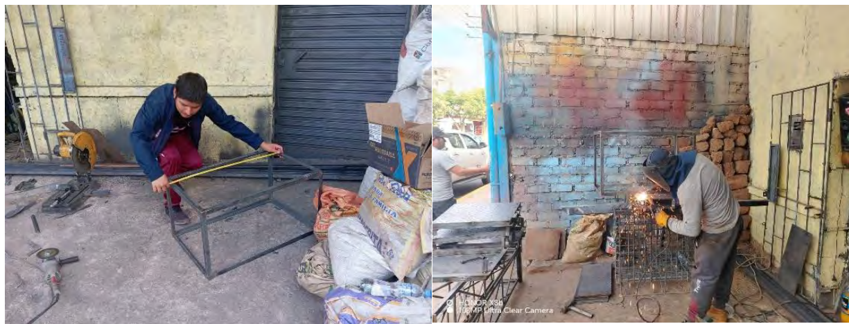
Figura 49. Construcción de marco experimental con perfiles de acero.
