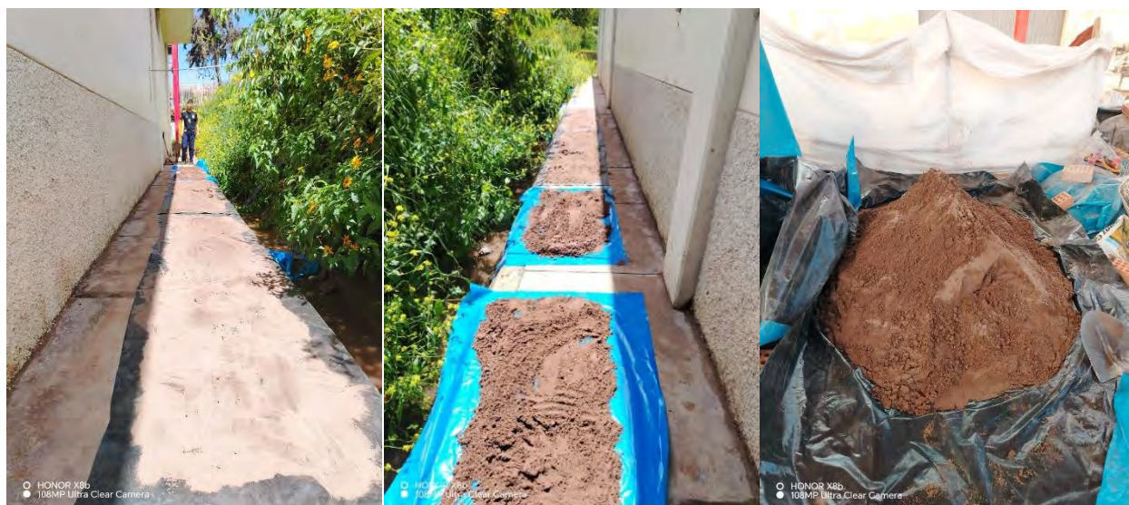
Figura 53. Secado de material para armado de modelo a escala.
