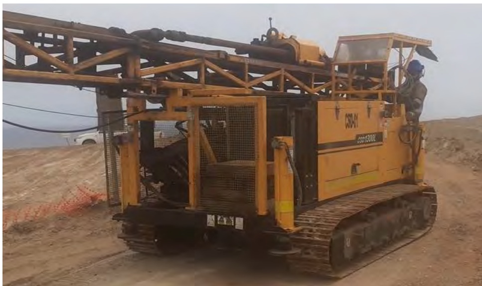
Figura 15 Desplazamiento de equipo de perforación. (Fuente: Propia).
