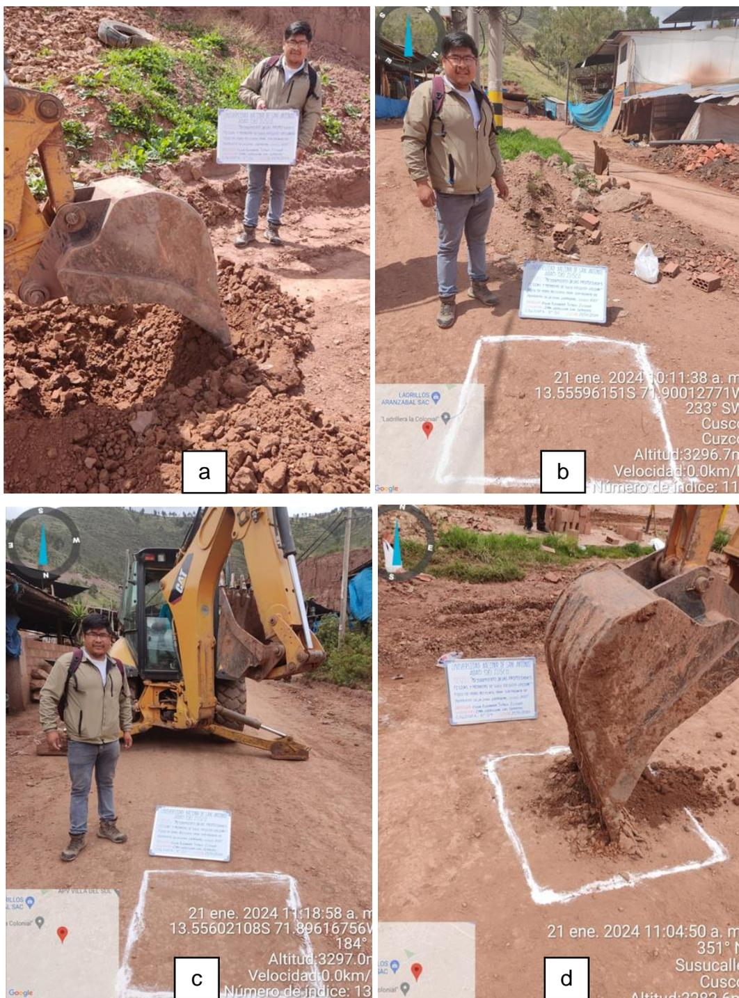
**Nota.** En las figuras a, b, c y d podemos observar las ubicaciones y excavaciones de los puntos de exploración para poder obtener las muestras de suelo arcilloso.
