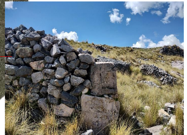
Vista del vano de acceso orientado al
