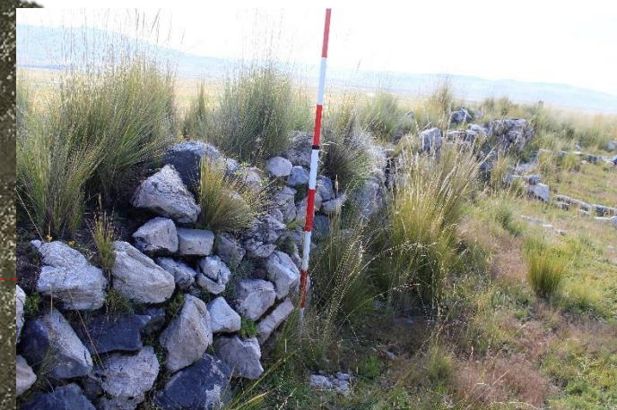
Paramento del muro de la muralla I, lado Norte; notese la mampostería rústica.
