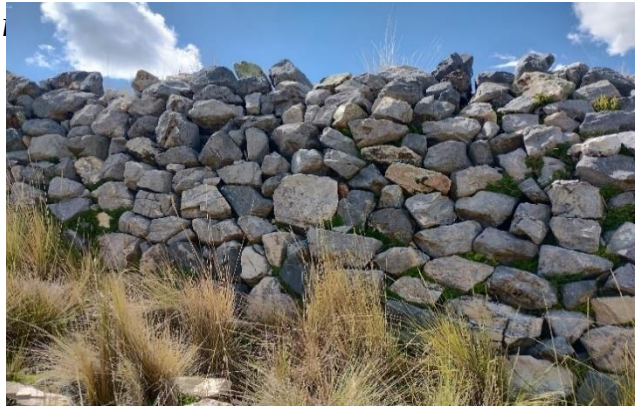
Paramento del muro de la muralla III
