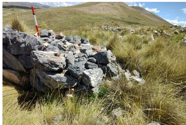
Vista del ancho del muro de la muralla II
