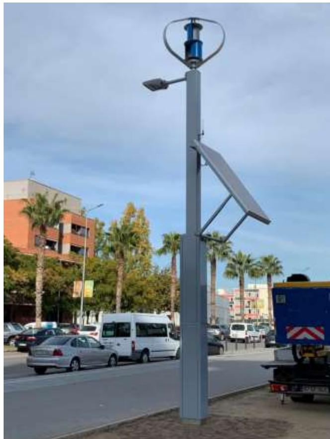
Fuente: ETNEO, Farolas inteligentes con micro aerogeneradores, solares y baterías
