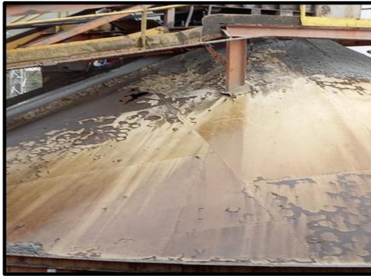
**Punto 05:** Se observo el pedestal del silo con corrosión y pintura en mal estado.
