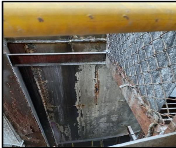
**Punto 04:** Se observo la presencia de corrosión, pintura en mal estado, forados en las planchas en la parte superior de la cúpula de la estructura del silo.
