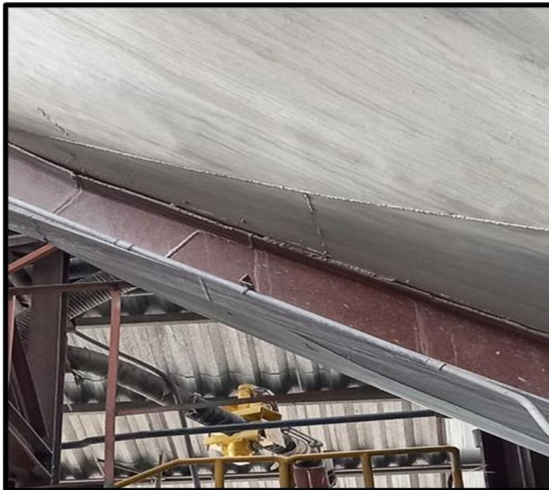
**Punto 03:** Se observo la presencia de corrosión de la plancha, pintura en mal estado en todo el alrededor de la parte inferior y superior del SILO SANTA MARIA.
