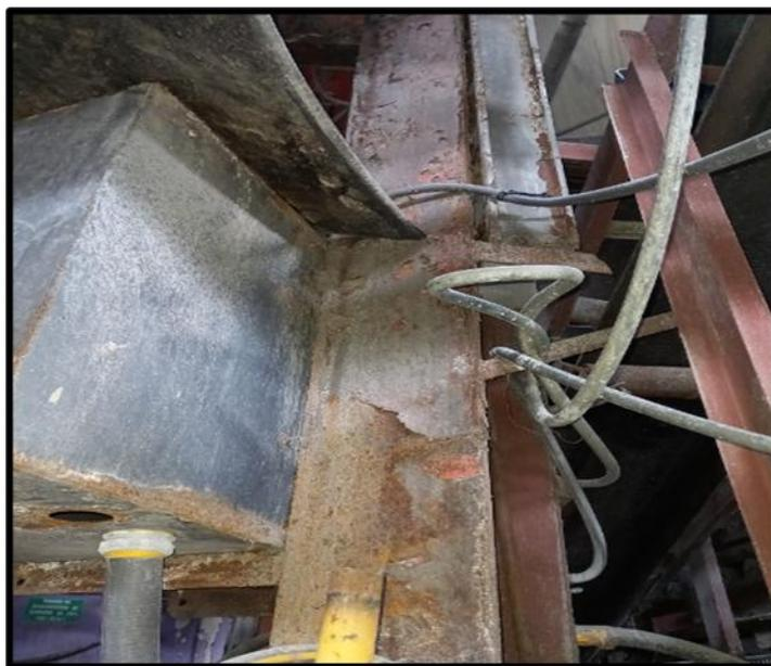
**Punto 06 y 07:** Se observo el pedestal de concreto con aristas fracturas.
