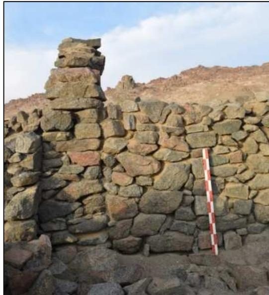
**Nichos:** Se identifico un total de cuatro nichos tipo distribuidas de forma equidistante al interior de la estructura, presentan forma rectangular cuyas medidas promedio son de 0.35 m de altura, 0.29 m de ancho de la base y una profundidad de 0.25 m (ver plano de elevación en Anexo 05, plano 10).
