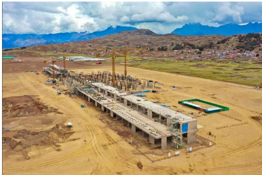
Figura 10. Aeropuerto de Chinchero en construcción
