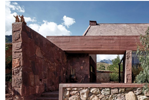
Figura 112. Pórtico de acceso
