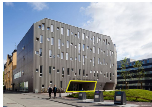
Figura 113. Acceso a la residencia
