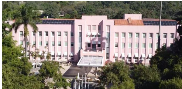
Figura 79. Fachada del hotel
