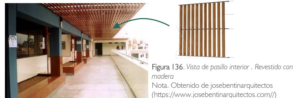
Figura 136. Vista de pasillo interior. Revestido con madera
