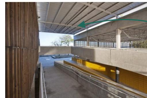
Figura 111. Techo prefabricado.
