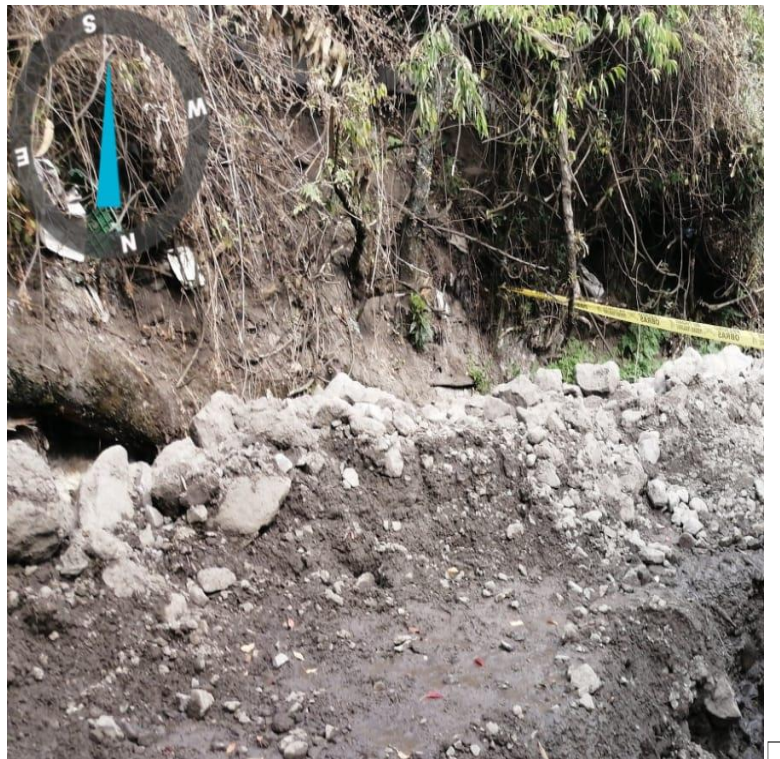
Fotografía de sección de cauce, a la altura de la 8va vivienda.
