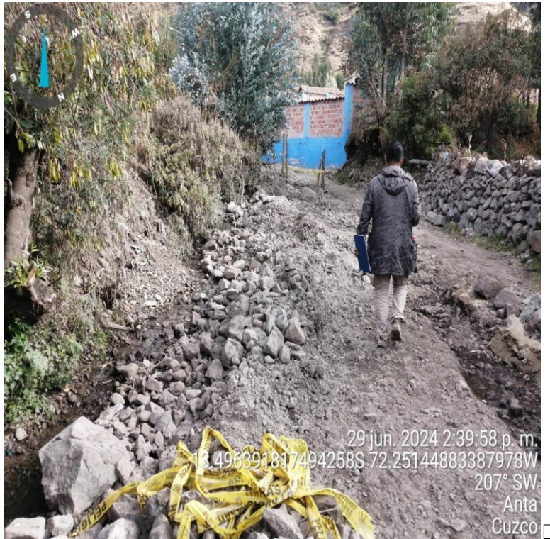
Fotografía de Canal de circulación de caudal.
