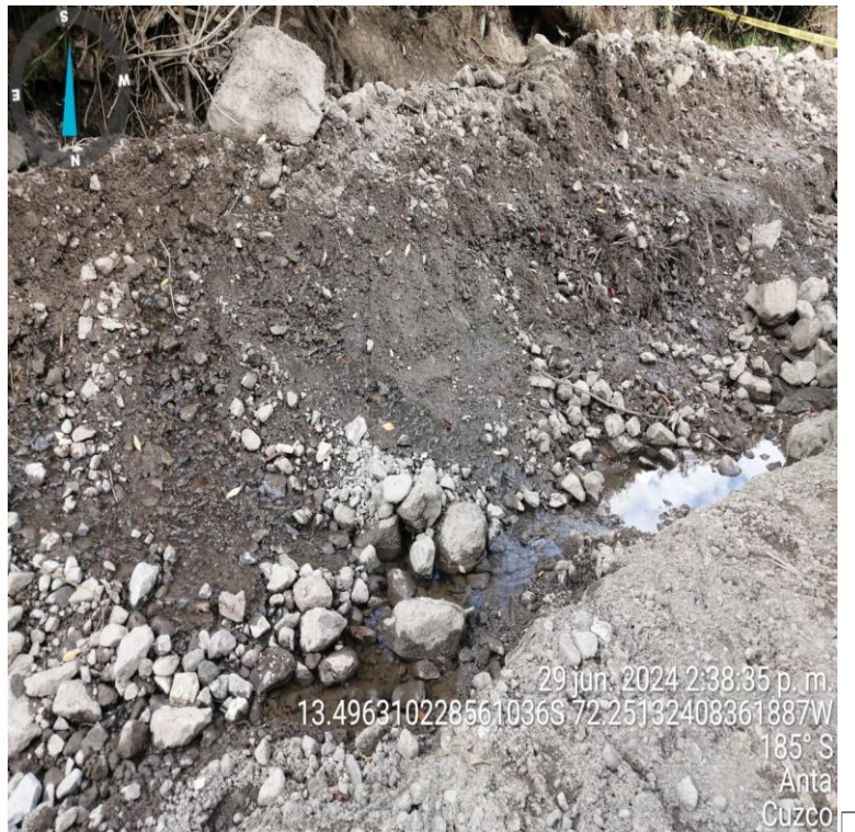
Fotografía de Canal de circulación de caudal.
