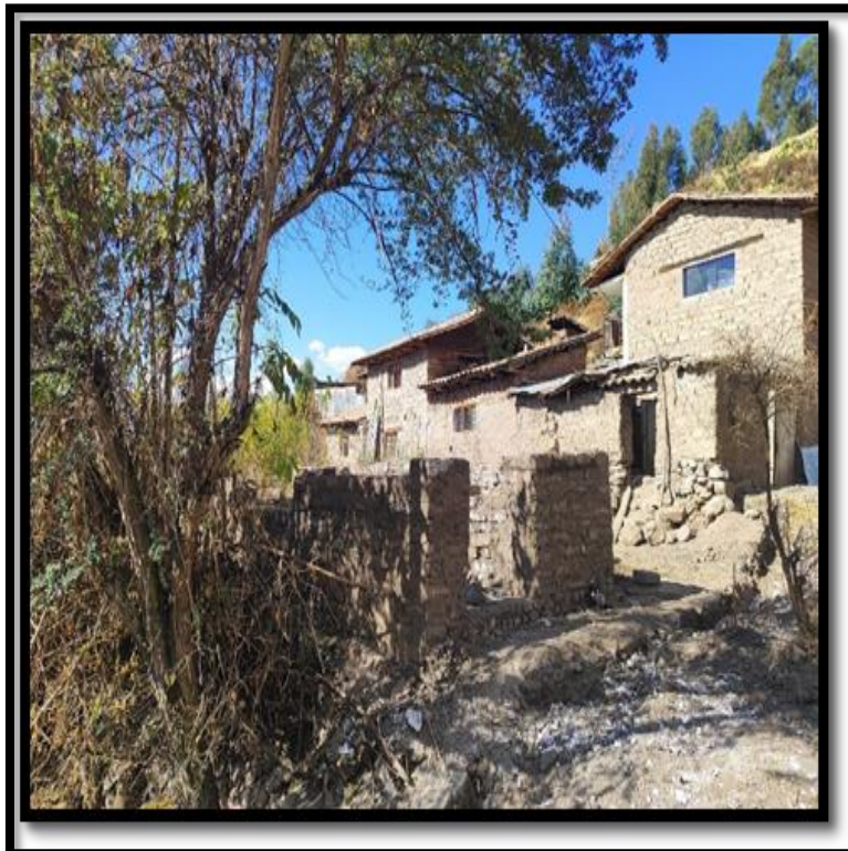
Fotografía de sección de cauce, a la altura de la 6ta vivienda.
