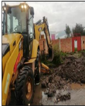
Trabajos de limpieza
