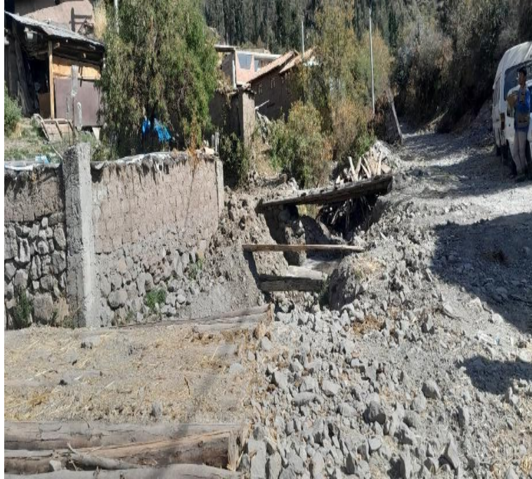
Fotografía de Presencia de obstáculos como puentes provisionales.
