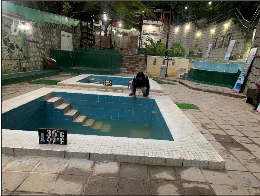
Figura 114. Medición de la altura de la piscina N°6.
