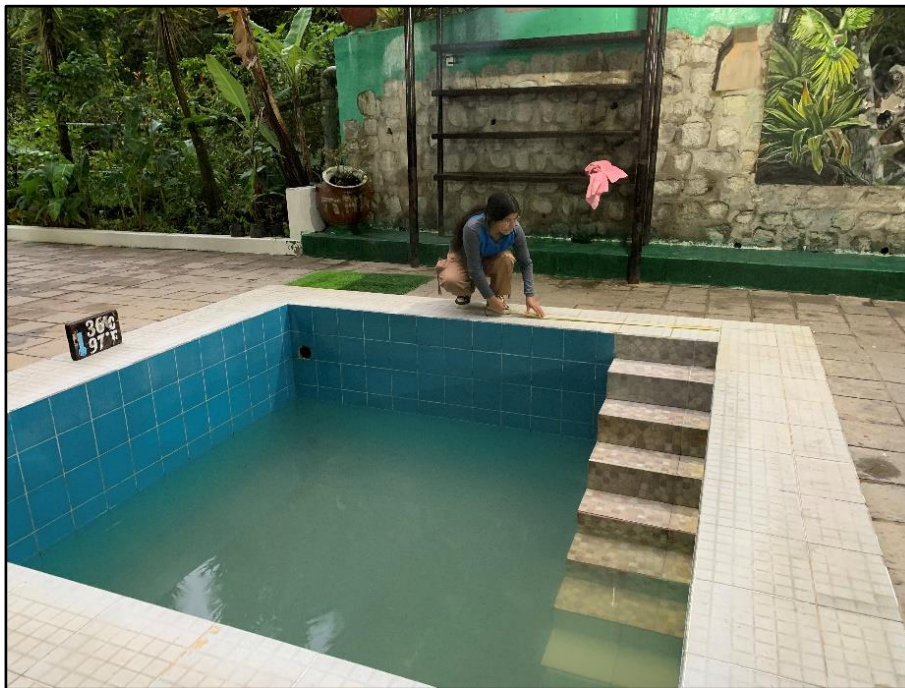
Figura 115. Medición del largo de la piscina N°6.
