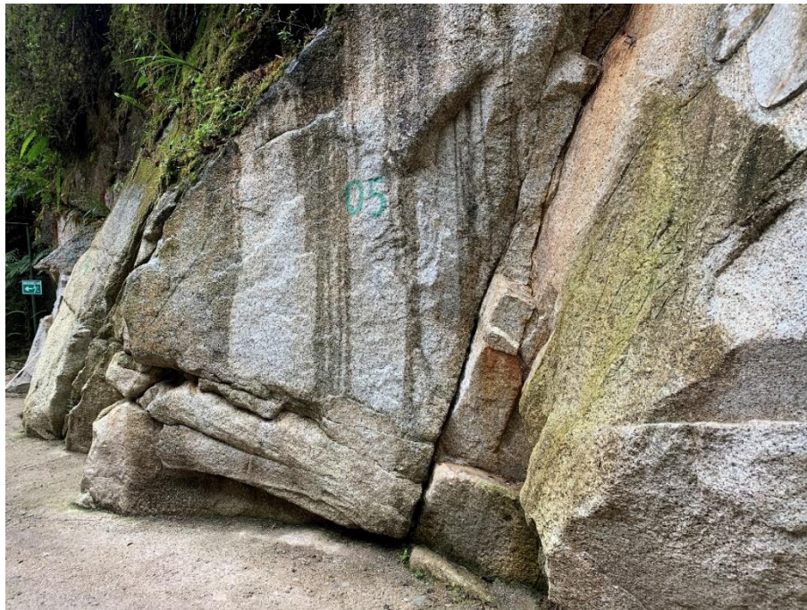
Figura 100. Se muestra una imagen del talud a la altura del puente
