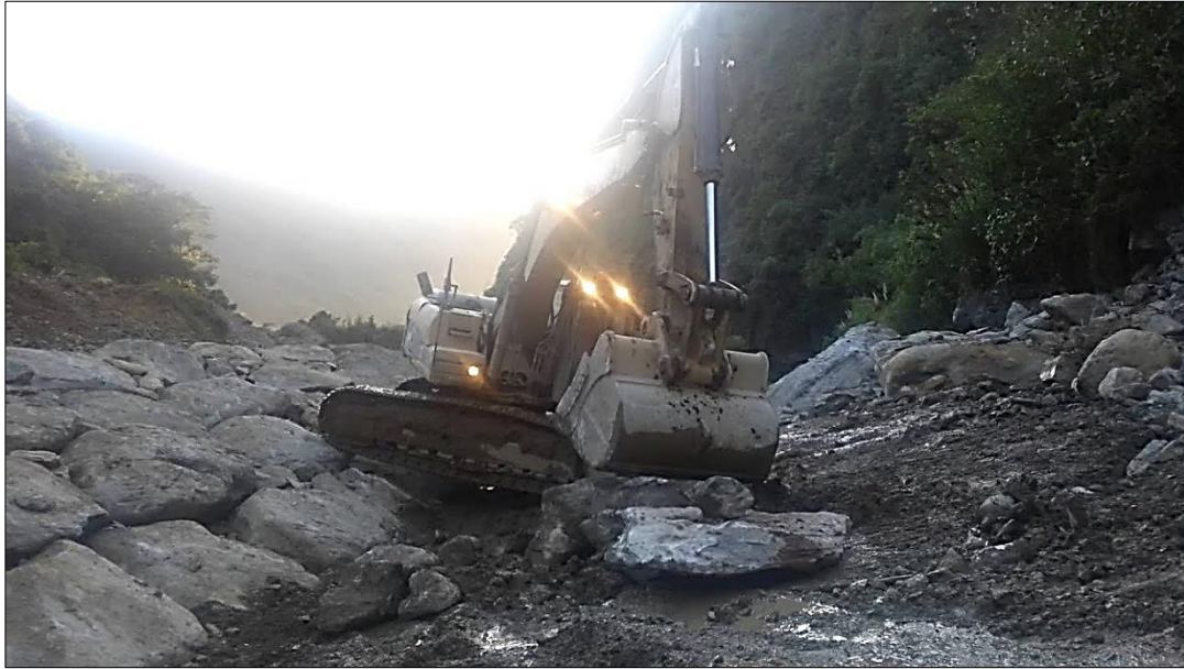
Figura 105. Enrocado con muro seco en el cauce del río Huaura-Sayán.
