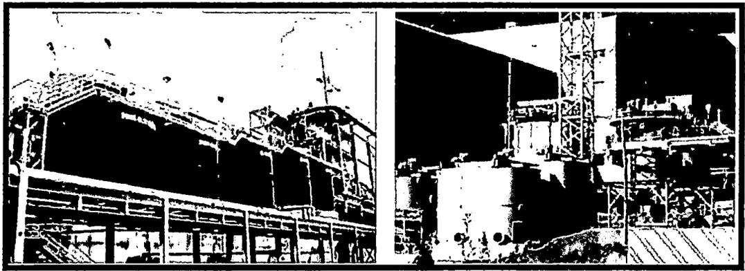
**Fig. 2.19: Celdas de flotación Dorr-Oliver de gran volumen instaladas en planta.**
