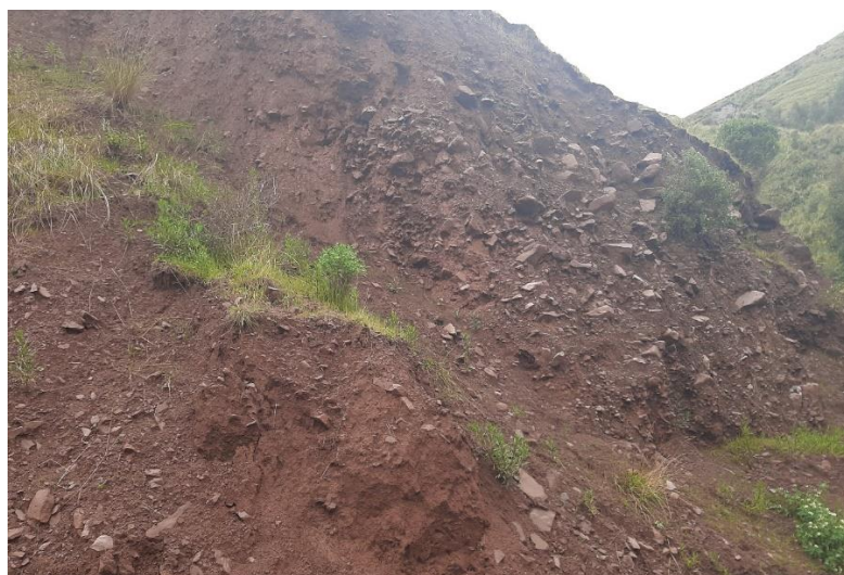
Figura 21 Presencia de clastos angulosos en matriz limo arcillosa
