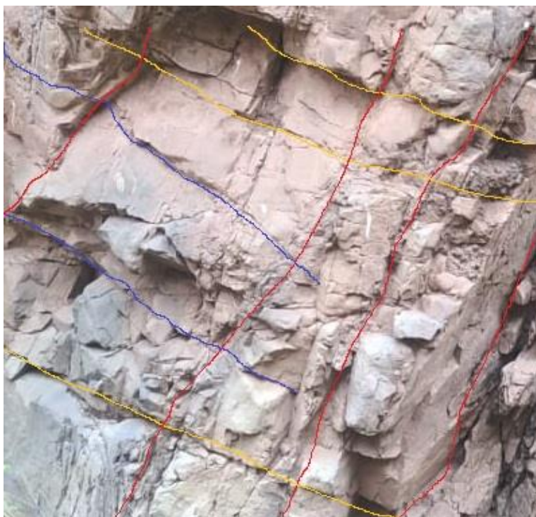
Figura 38 Ventana estructural de la Formación Kayra margen izquierda
