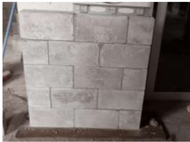
Imagen 17 Elaboración de murete con dos unidades por hilera
