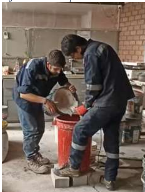
Imagen 11 Vertido de espuma en mezcla de mortero
