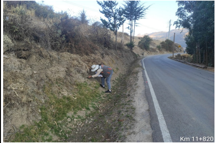
Fotografía 02:km 11+820 Identificación de materiales
