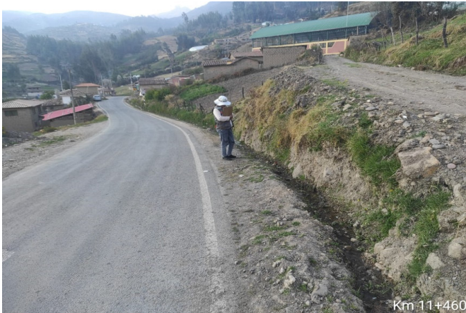
Fotografía 03:km 11+460 Depósito fluvio glacial compuesto por bloques y clastos angulosos a subangulosos en una matriz arcillo limosa.
