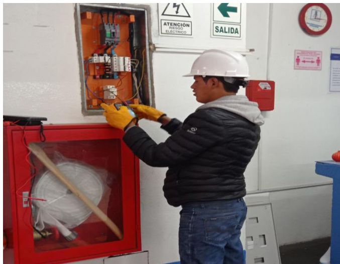
Figura 3.5 Fotografía 2 mediciones en el tablero principal. Fuente: Propia.
